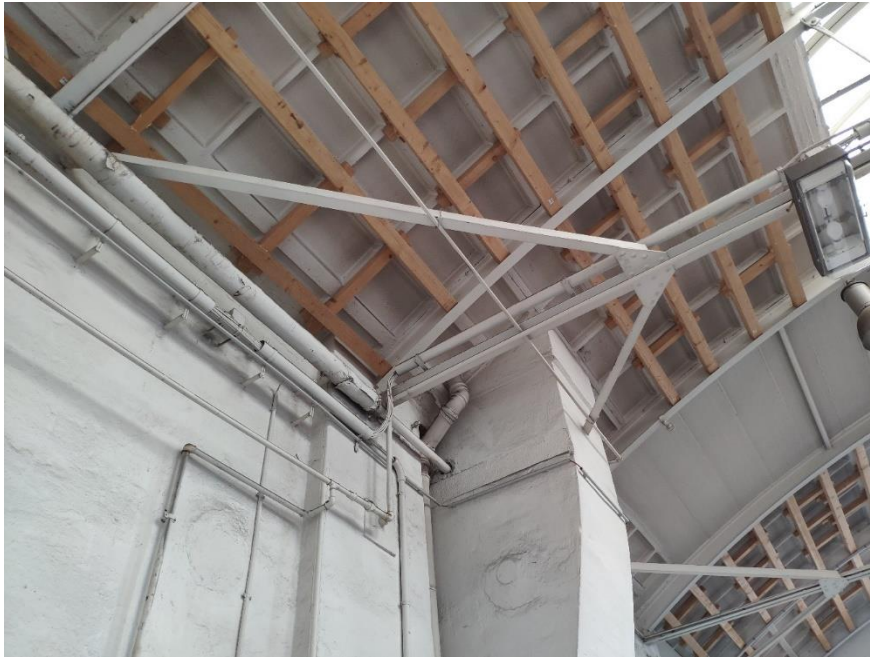
Unterstützungsstruktur und Fehlstellenreparatur im Außenschiff Westen
