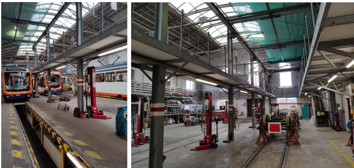
Fangnetze im mittleren Hallenschiff
