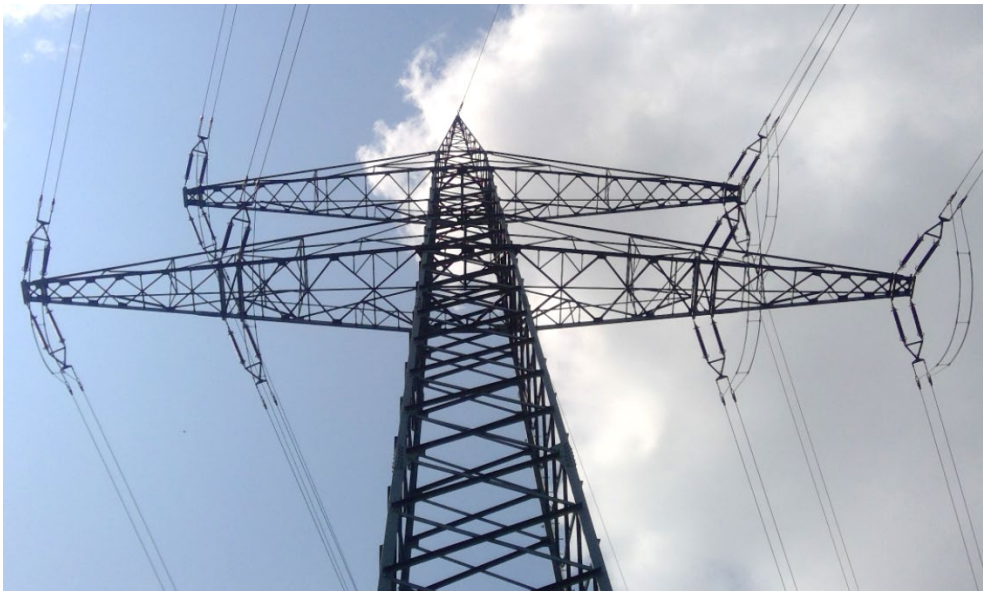
Abbildung 5: Beispiel Doppelabspannketten für 110-kV; 2er-Bündel (MVV)
