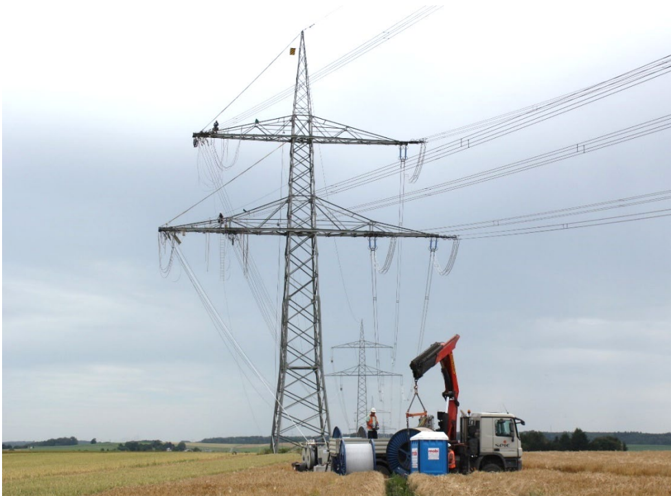
Abbildung 14: Beispiel Seilzugarbeiten (Trommelplatz)
