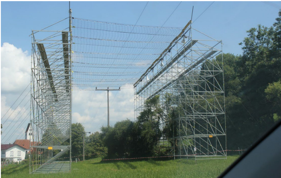
Abbildung 12: Beispiel Schutzgerüst über Niederspannungsleitung
