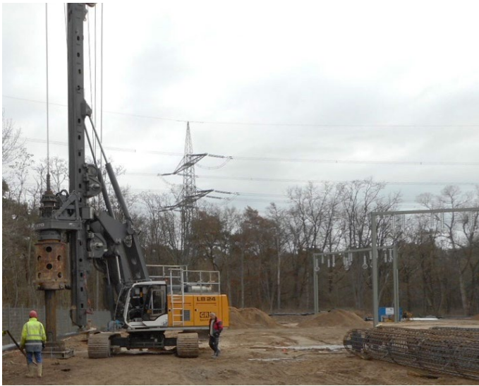
Abbildung 9: Beispiel Bohrgerät für Bohrpfahlfundament, rechts die Bewehrungskörbe für die Bohrpfähle
