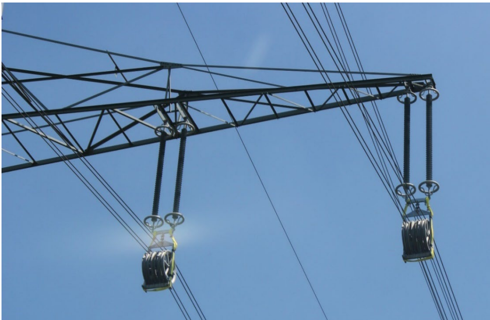
Abbildung 13: Beispiel Seilrollen an Isolator Ketten befestigt
