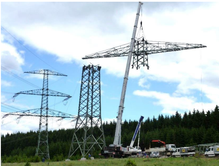
Abbildung 10: Beispiel Masterrichtung (Mast stocken)
