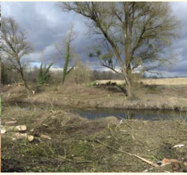
Künftig fließt der Schutterentlastungskanal hier in die Wittweiberkehle.
