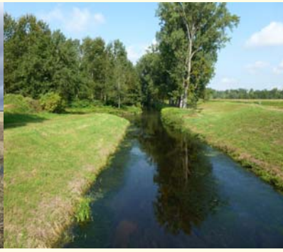
Der Schutterentlastungskanal erhält ein neues Gewässerbett.
