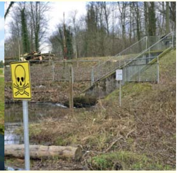
Der bestehende Düker wird ersetzt und die Gefahrenstelle beseitigt.
