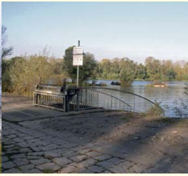
Bestehendes Mündungsbauwerk am Ottenheimer Altrhein
