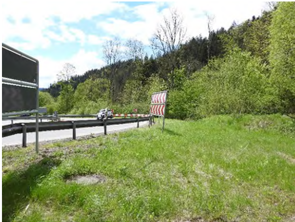
Blick auf die Spitzkehre im Bereich des Portal Ost mit Blickrichtung Westen
