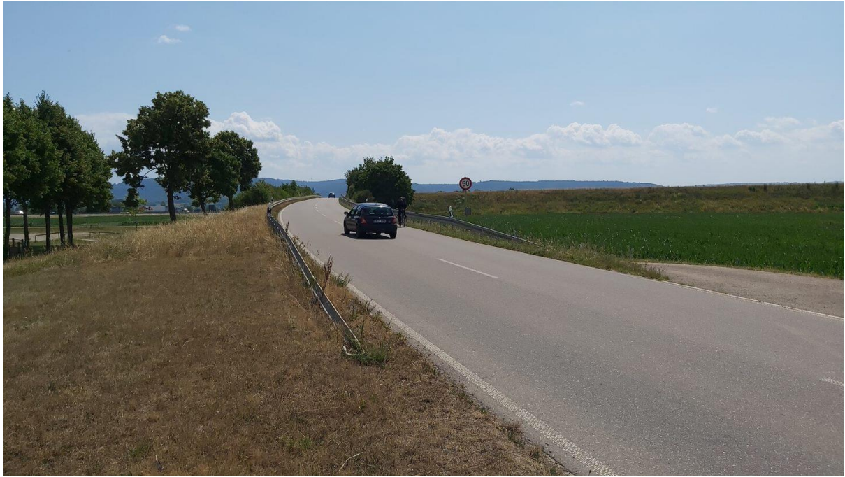
Abbildung 1: Blick auf die Brücke vom westlichen Rampenende im Juni 2022.
