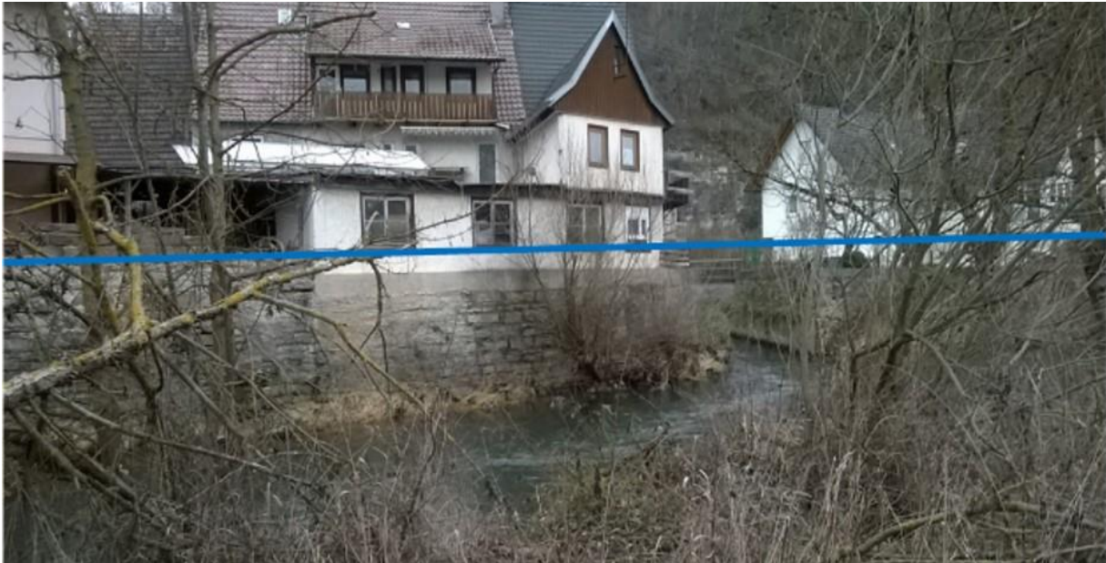
Abbildung 2: Unmittelbare Bebauung des Neckars: Blick auf die Einleitung des TW-Kanals in den Neckar mit eingezeichneter HQ 100 -Linie
