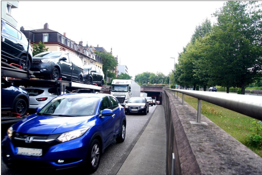
Abbildung 4.1-4: Schützenallee tunnel Ausfahrt (Fahrtrichtung Westen) an der Einmündung in die Schwarzwaldstraße (Bildquelle: Regierungspräsidium Freiburg, 2018).
