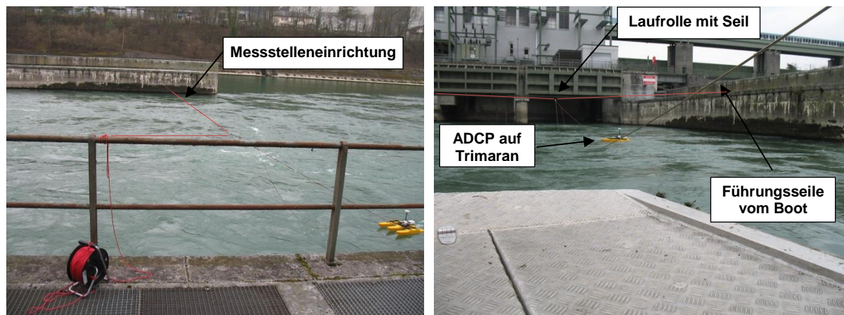
Abb. 7: Seilkonstruktion zur Erfassung der Strömungsverteilung im Unterwasser des Kraftwerks Reckingen
