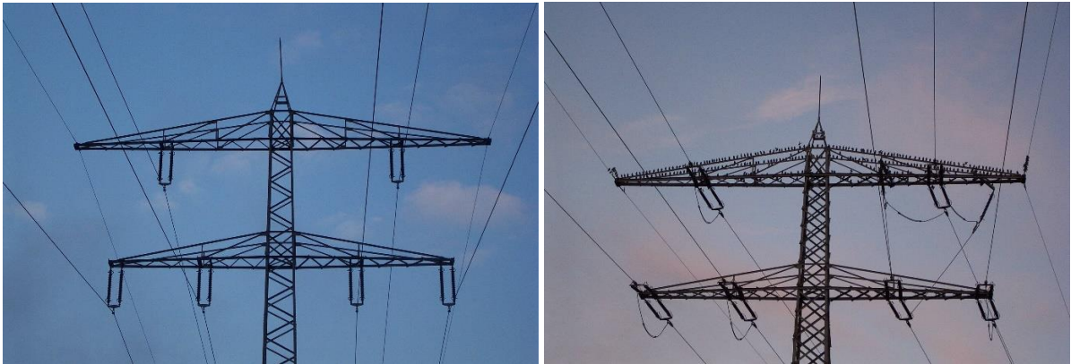
Abbildung 4: Bestehende Masten 028 (T) und 024 (WA) der 110-kV-Leitung mit Einfachseil
