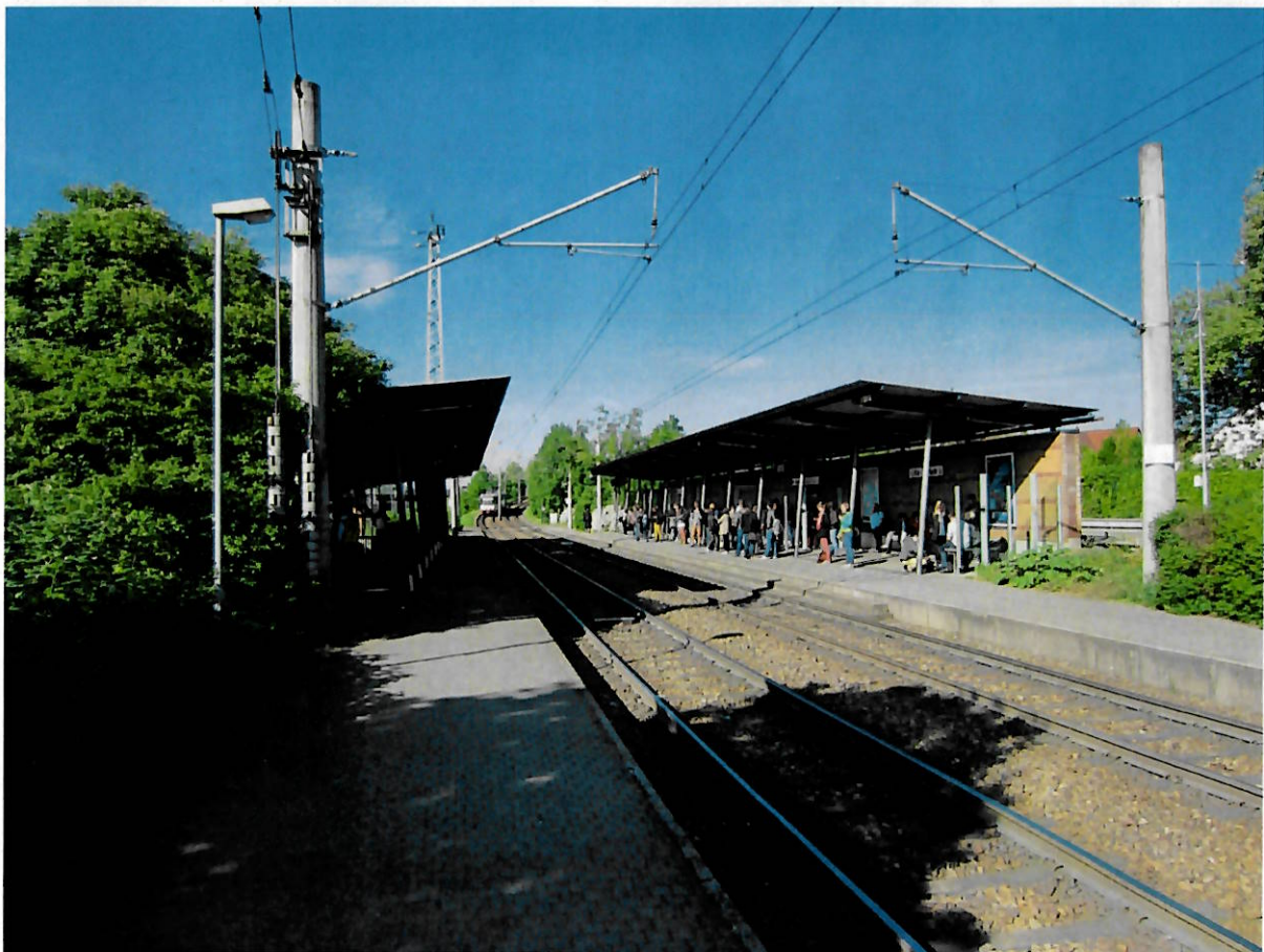
Bild 1: Bf. Durlach, Gleis 11 und 12, im Hintergrund die Rampe zur Durlacher Allee
