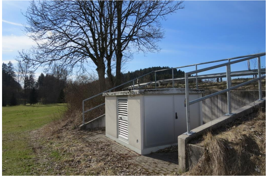
Abb. 10: Blick nach Süden: Trafogebäude östlich der L 406 im Böschungsbereich (Foto: faktorgruen: 01.03.2022)
