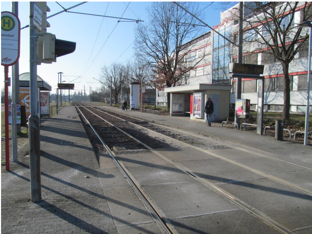
Abbildung 3: Haltestelle Fächerbad, Blickrichtung Karlsruhe Innenstadt
