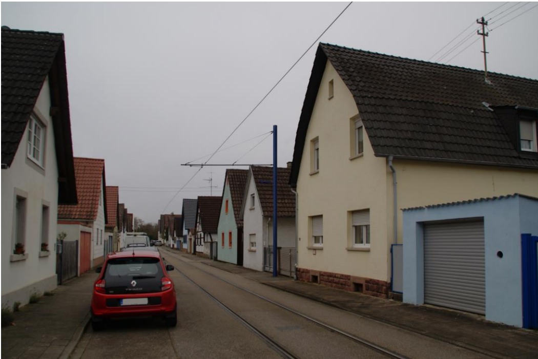
Abbildung 42: Rappenwörtstraße – Neubau (Maststandort R7)
