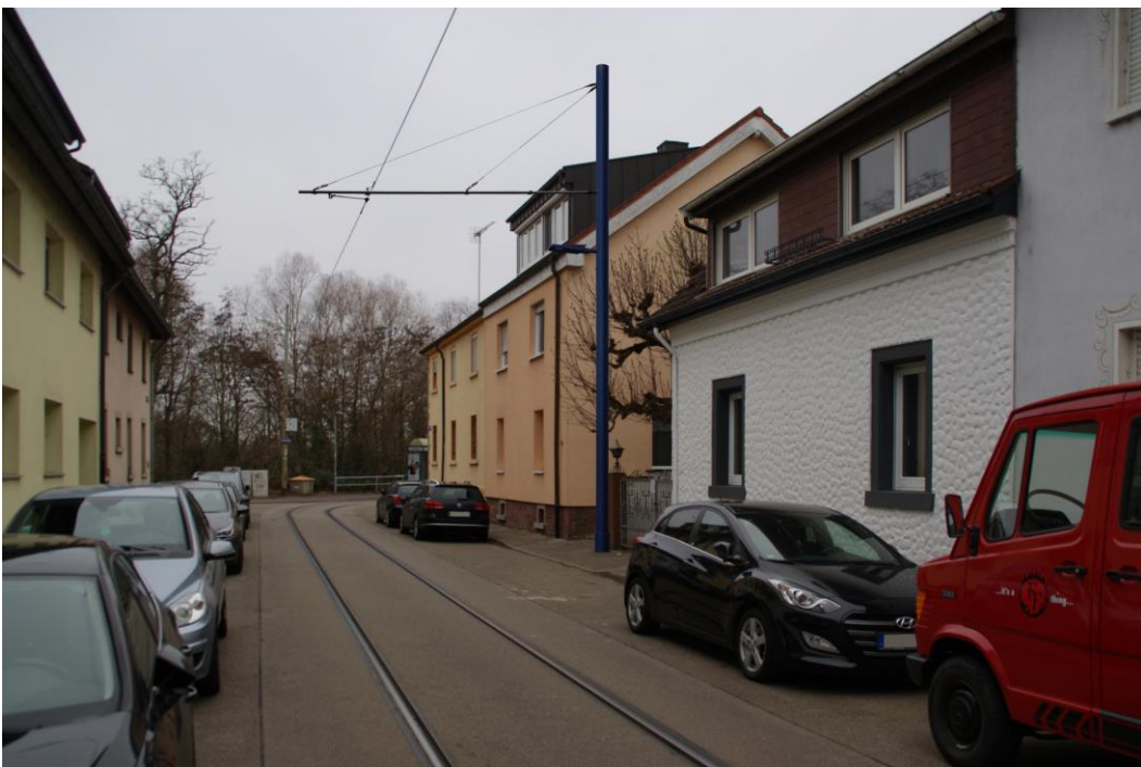
Abbildung 32: Kastenwörtstraße – Neubau (Maststandort K26)
