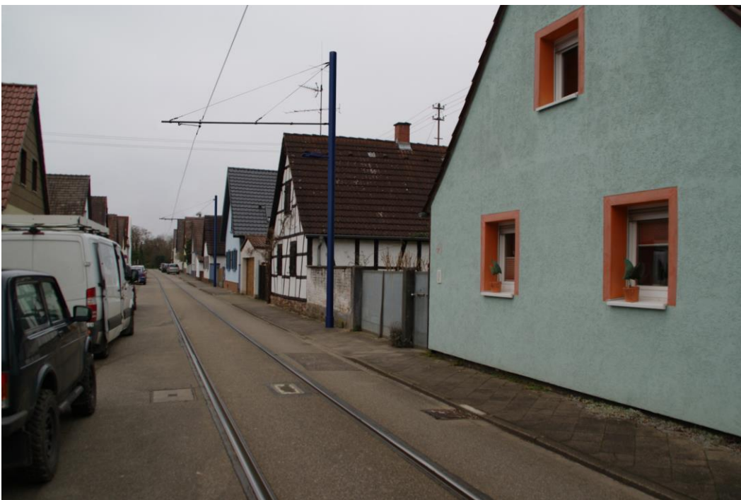
Abbildung 44: Rappenwörtstraße – Neubau (Maststandort R8-R9)
