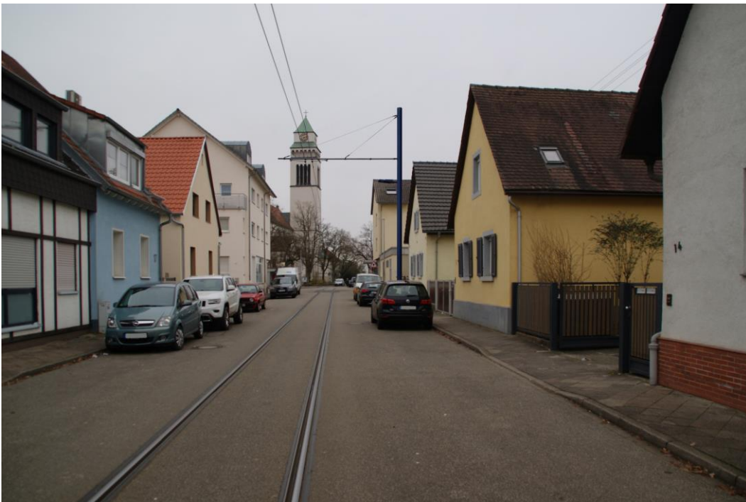
Abbildung 16: Kastenwörtstraße – Neubau (Maststandort K11)
