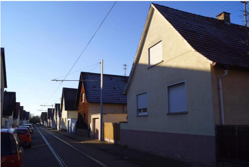
Abbildung 40: Rappenwörtstraße – Neubau (Maststandort R6-R7-R8)
