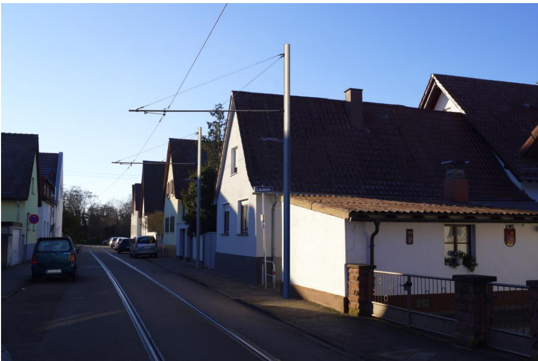
Abbildung 46: Rappenwörtstraße – Neubau (Maststandort R10-R11)
