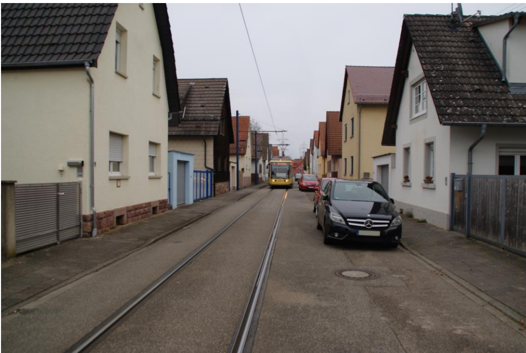
Abbildung 38: Rappenwörtstraße – Neubau (Maststandort R5-R6)
