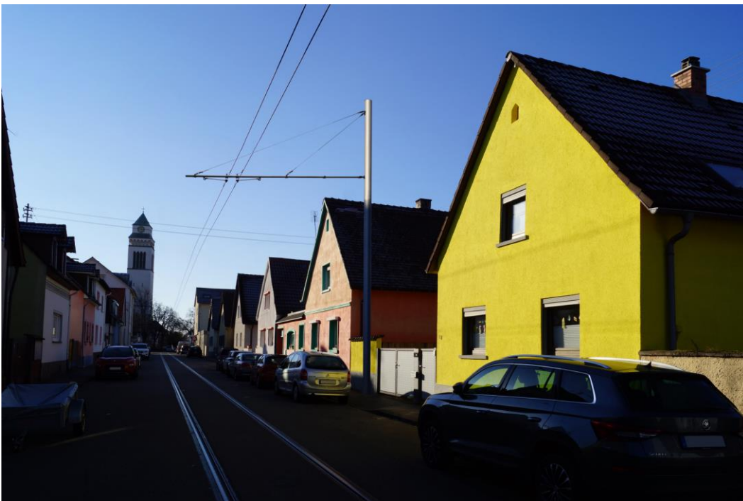
Abbildung 4: Kastenwörtstraße – Neubau (Maststandort K8)
