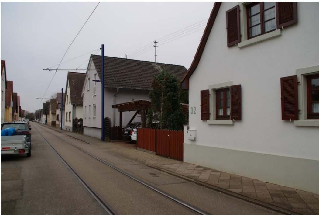
Abbildung 36: Rappenwörtstraße – Neubau (Maststandort R3-R4)
