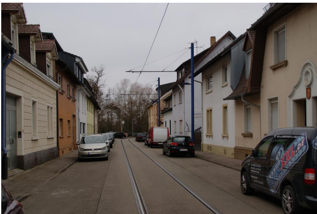
Abbildung 30: Kastenwörtstraße – Neubau (Maststandort K25-K26)
