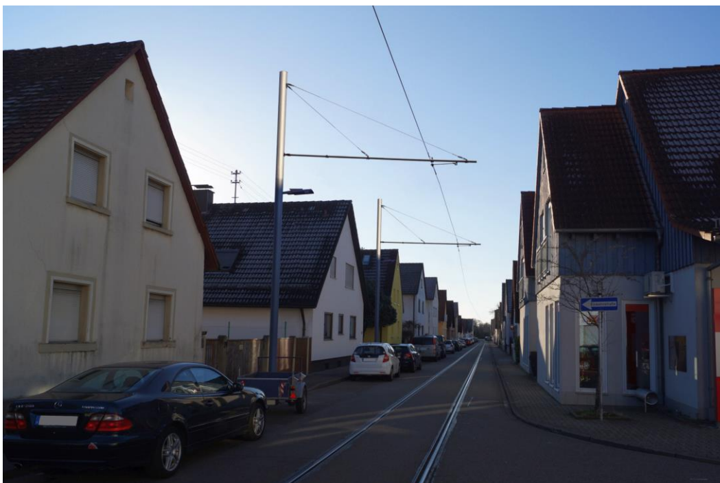
Abbildung 34: Rappenwörtstraße – Neubau (Maststandort R1-R2)
