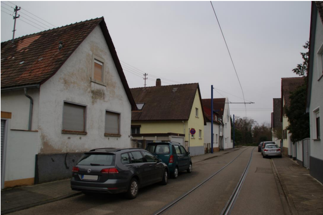
Abbildung 48: Rappenwörtstraße – Neubau (Maststandort R12-R13)
