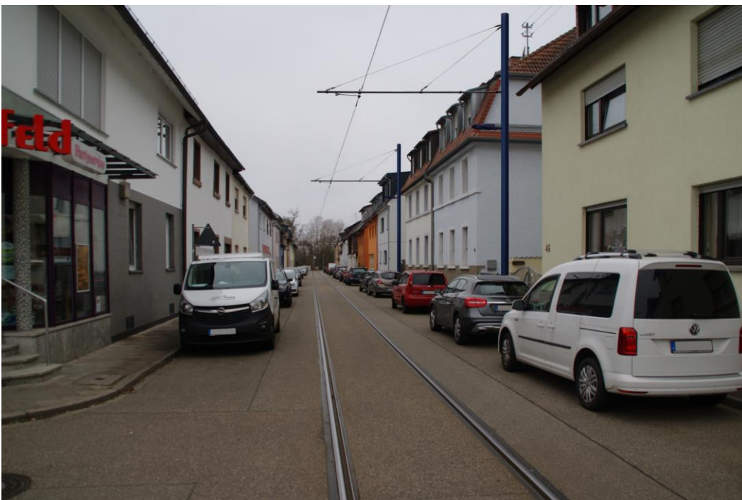
Abbildung 26: Kastenwörtstraße – Neubau (Maststandort K22-K23)
