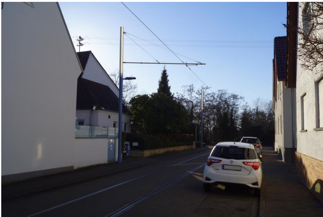
Abbildung 50: Rappenwörtstraße – Neubau (Maststandort R13-R14)
