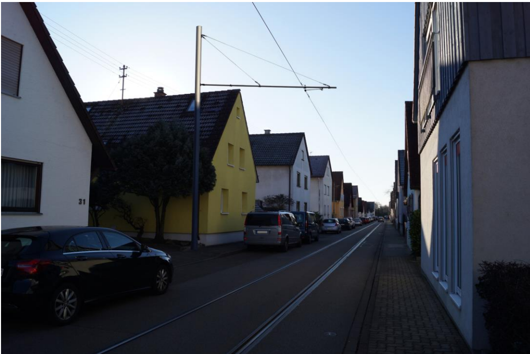
Abbildung 52: Rappenwörtstraße – Neubau (Maststandort R2)
