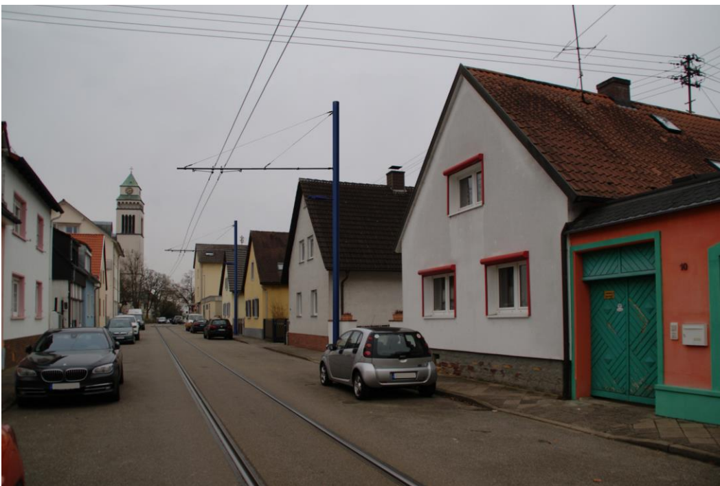
Abbildung 14: Kastenwörtstraße – Neubau (Maststandort K9-K10)
