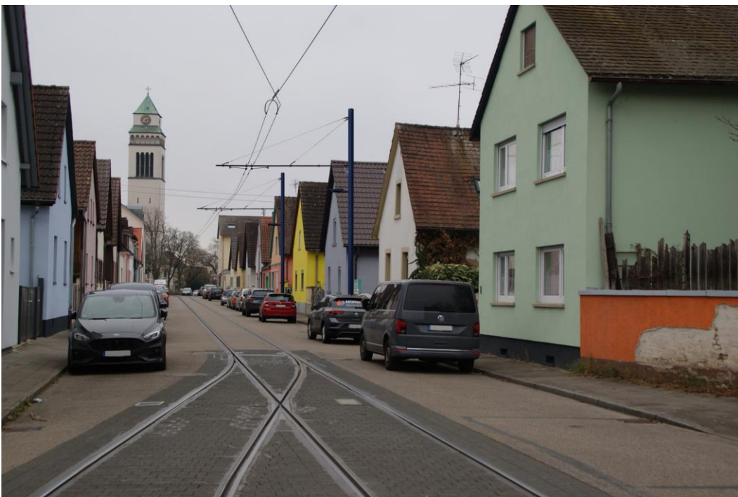
Abbildung 8: Kastenwörtstraße – Neubau (Maststandort K7-K8)
