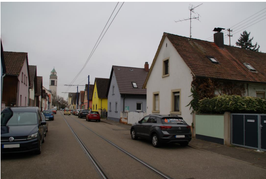
Abbildung 12: Kastenwörtstraße – Neubau (Maststandort K8-K9)
