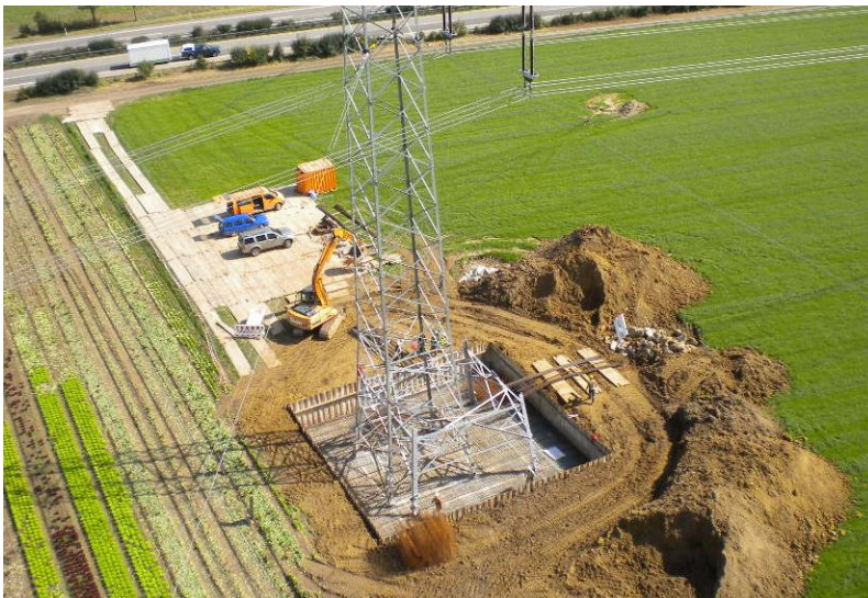
Abbildung 7: Baustelleneinrichtung mit Fundamentgrube
