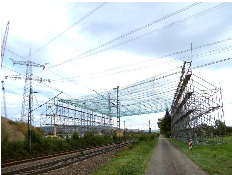
Abbildung 8: Schutzgerüst
