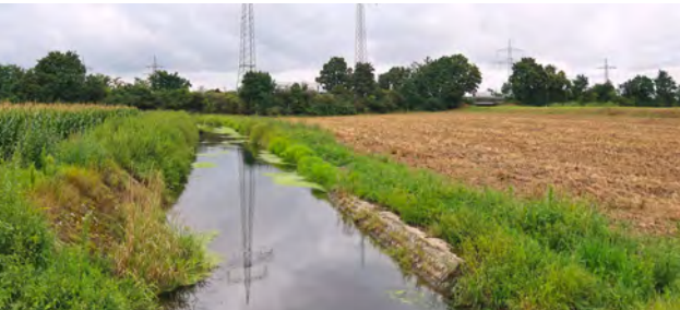
△ Der bestehende Landgraben mit Einleitstelle und gegenüberliegendem Böschungspflaster sowie angrenzender landwirtschaftlicher Flächen: Blick in Fließrichtung von Osten auf die BAB A5
