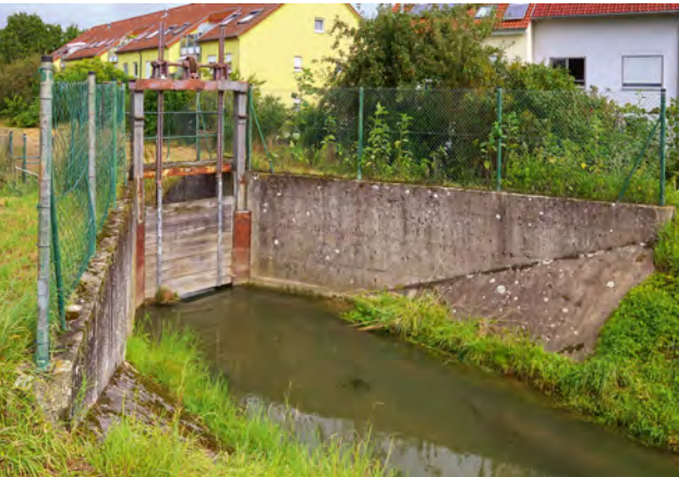
△ Die bestehende Schützenanlage und der Sohlabsturz am Leimbach bei Oftersheim
