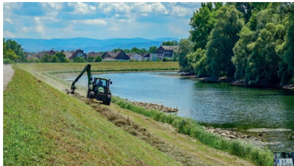
▲ ganz oben: Uferbefestigung mit Weidenstecklingen (Foto: RPK)
