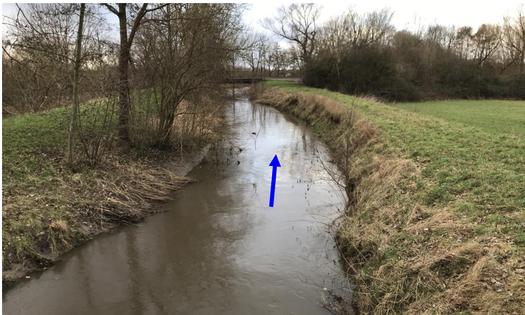
Abbildung 3.1 Kraichbach oberstrom des Bahndurchlasses. Deutlich zu sehen: steile Ufer, Gehölze auf dem Damm, strukturloses Gewässer
