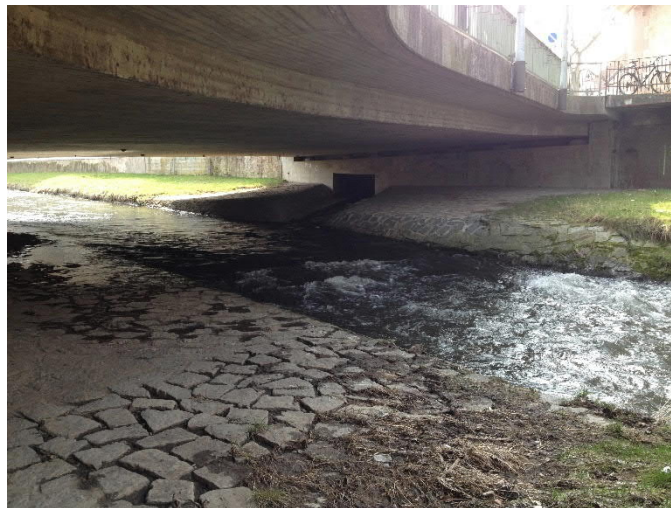
Abbildung 4.1 Unruhiger Wasserspiegelverlauf im Zustrombereich des Pegels
