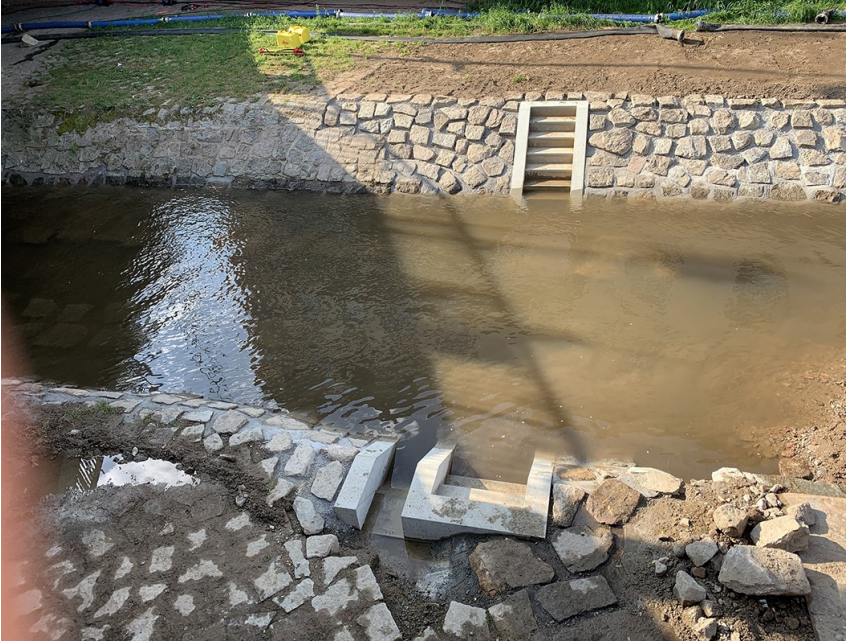
Pegeltreppen „Pegel Weinheim“ (Copyright WALD + CORBE Consulting GmbH) Die neuen Pegeltreppen an der Weschnitz wurden bereits hergestellt. Auch das Pflaster der Sohle und Böschungen wurde hergestellt. Ein Teil der Fugen ist noch zu verfüllen. In der Rinne neben der unteren Pegeltreppe wird zukünftig die Messtechnik zur Wasserstandsmessung verlegt.
