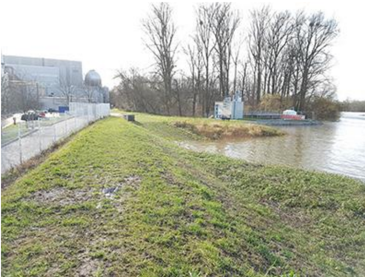
Der Rheinhochwasserdamm XXV am Rheinhafen-Dampfkraftwerk beim Hochwasser 2018 Bildautor: Regierungspräsidium Karlsruhe (RPK)
