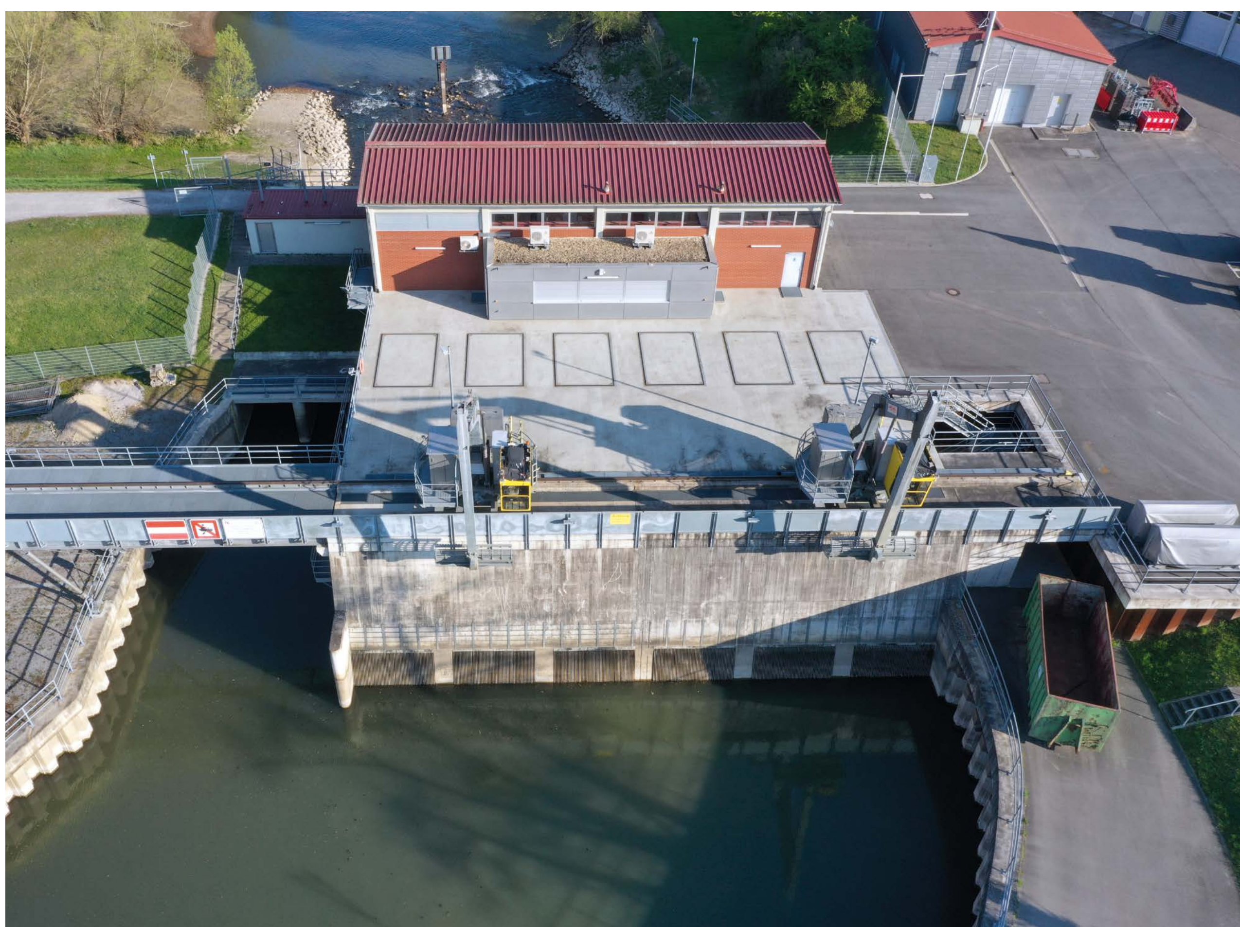
Das Schöpfwerk Philippsburg aus der Luft
