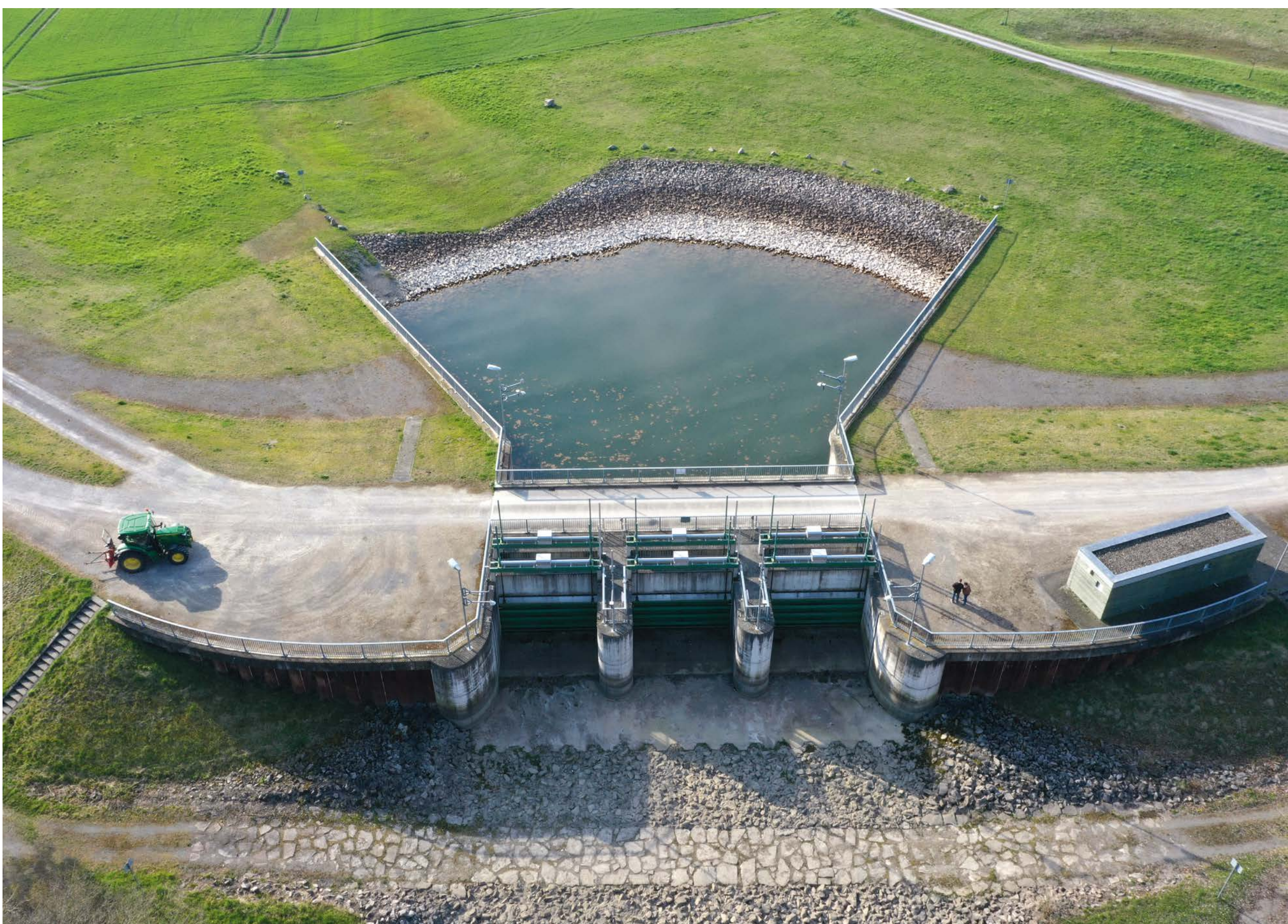
Ein- und Auslassbauwerk des Rückhalterausms
