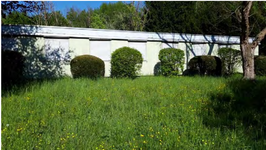
Abb. 10: Ostflügel des Bestandsgebäudes an der „Beinsteiner Straße“
