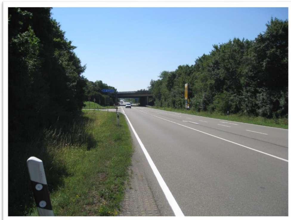
Foto 6: AS Kupferzell: Anschluss Rampe Nord an die B 19
