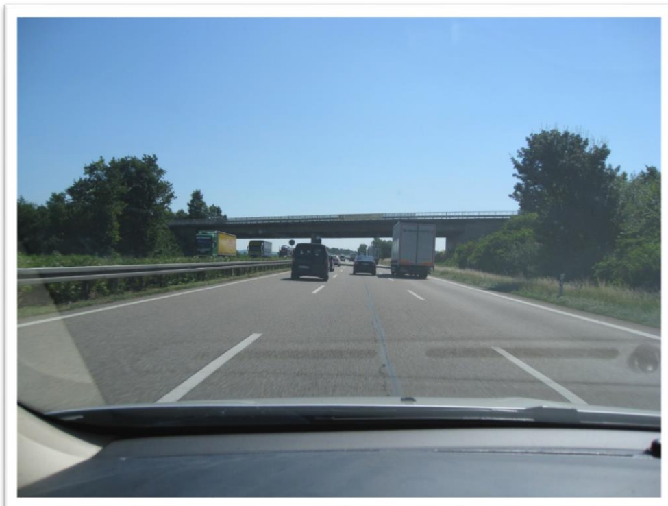
Foto 4: Überführung der L 1046 (Bau-km 7+016)
