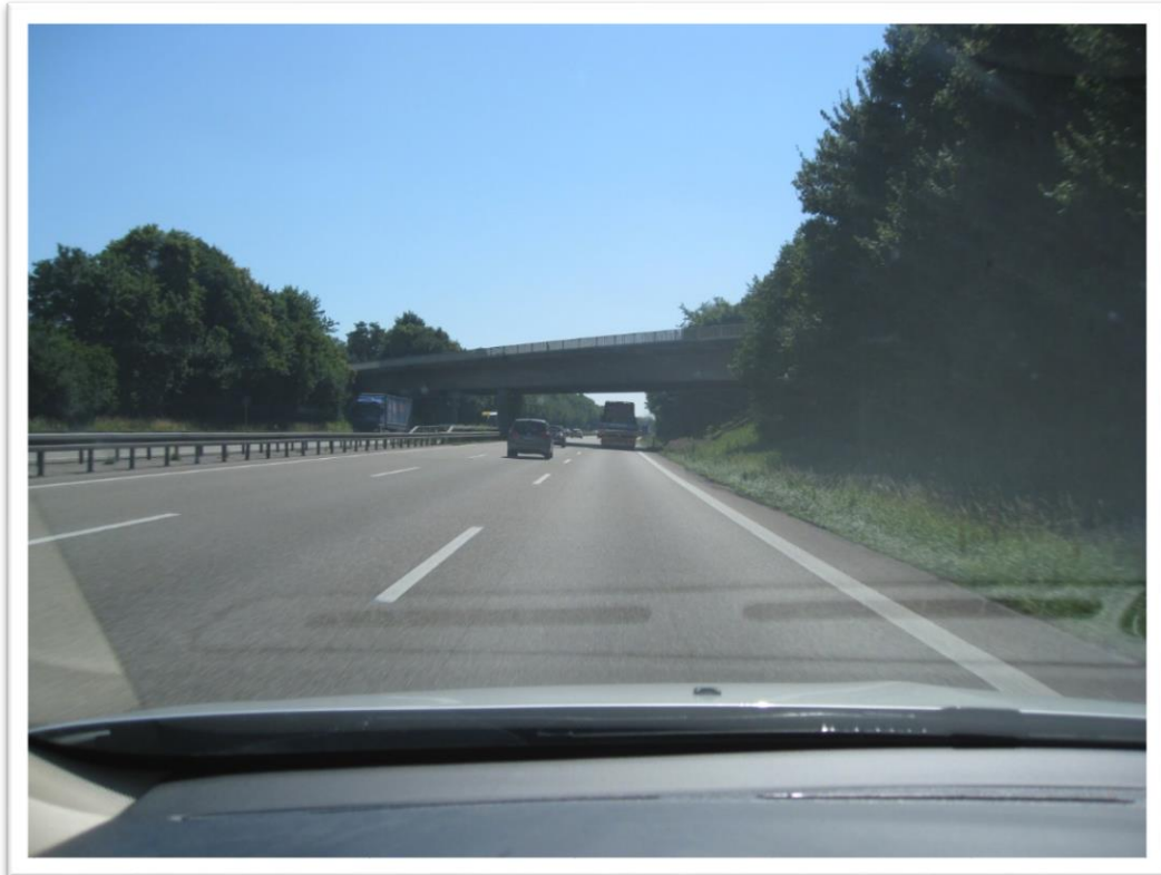
Foto 3: Überführung der L 1036 (Bau-km 3+466)
