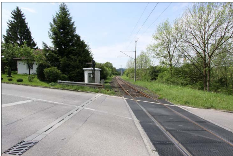
Abbildung 3 Blick von der BÜ in Richtung Süden (oben) und Norden (unten)
