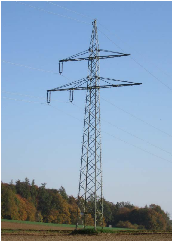
Abbildung 7: Mast 6 (Tragmast, Donaumast) der LA 0108
