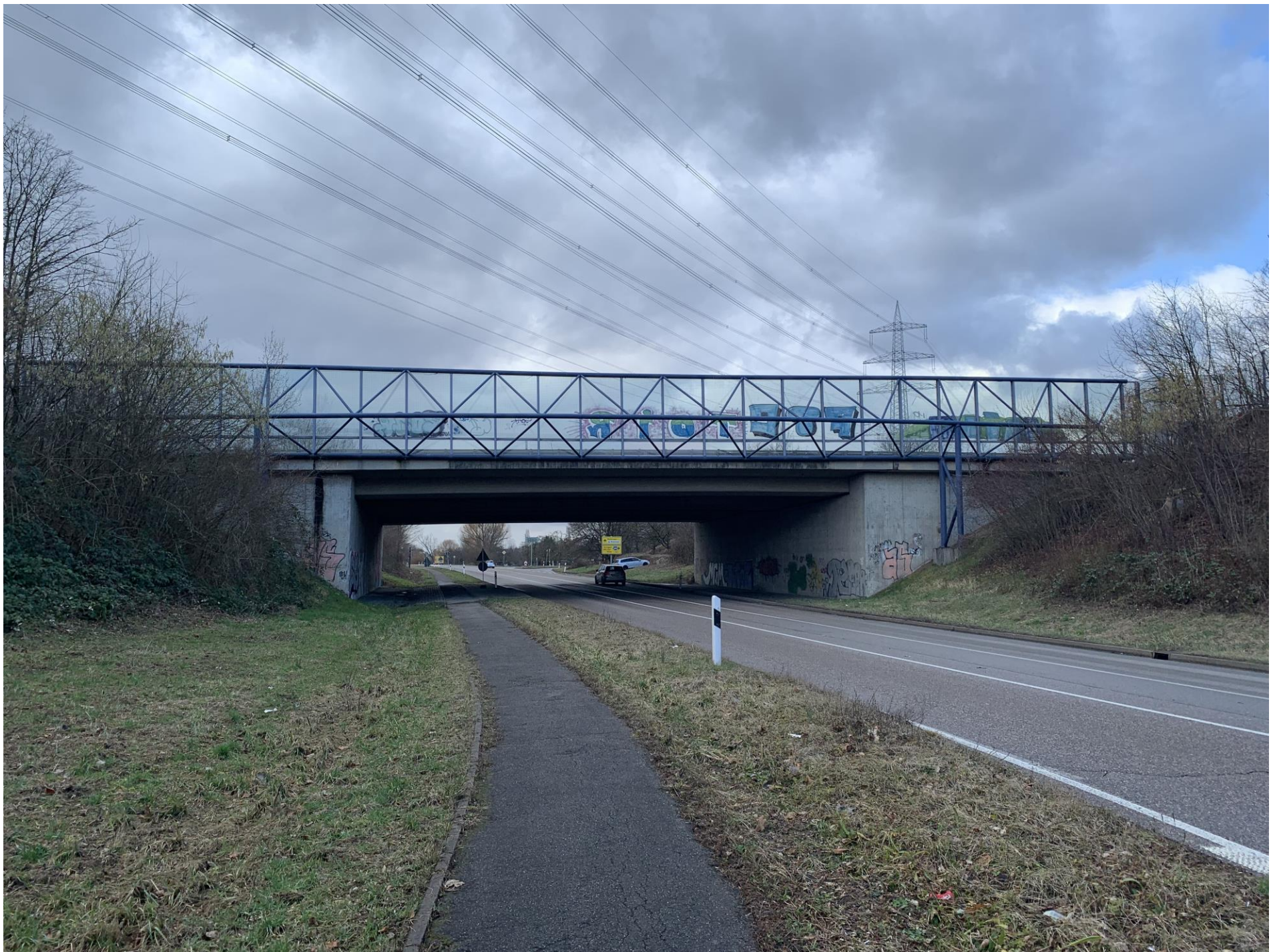
Bauwerk-Bestand Ansicht Ost (Teilbauwerk 1) mit vorgesetzter Lärmschutzwand
