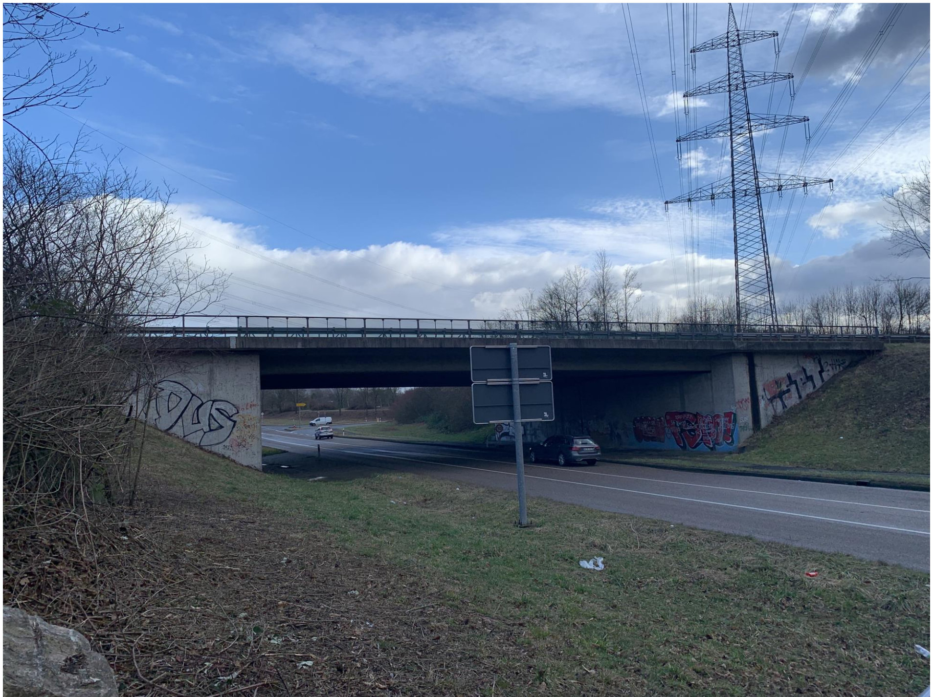
Bauwerk-Bestand Ansicht West (Teilbauwerk 2)
