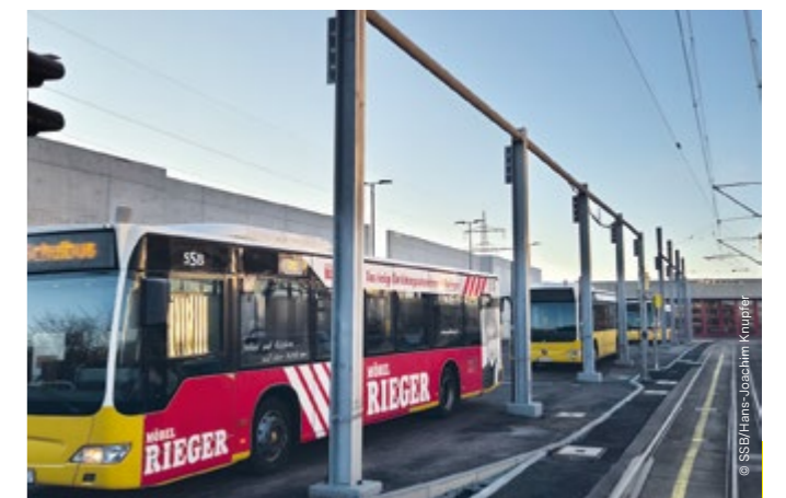
Ladegerüst zur Depotladung von Linienomnibussen.
