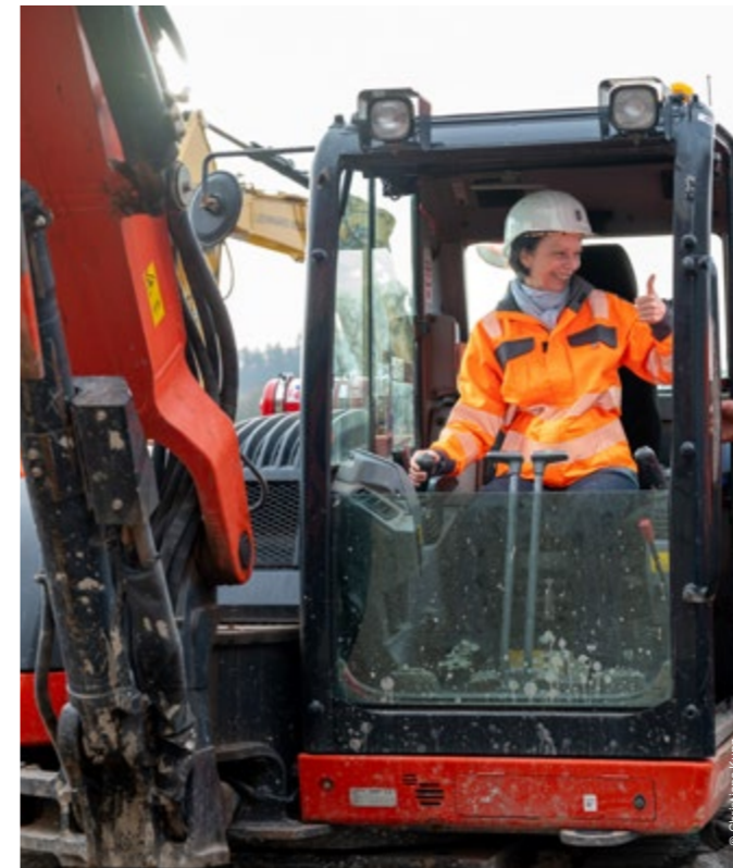
... als Tunnelpatin bei der tatkräftigen Unterstützung beim Tunnelanschlag für den Bau des neuen Rettungstollens des Schemelsbergtunnels.
