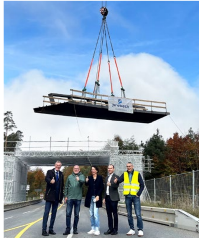
... beim Einhub einer 200 Meter langen Brücke für den Radschnellweg RS 1 zwischen Stuttgart und Böblingen.
