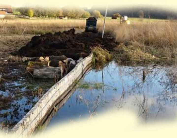
Spundwand zur Wiedervernässung
