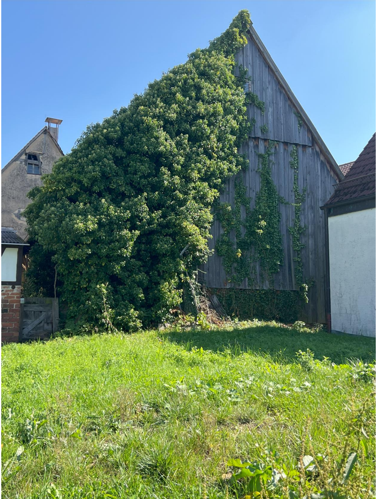
Scheuer 5/1 - Blick vom Nachbargrundstück, links im Hintergrund Scheuer 8/1
