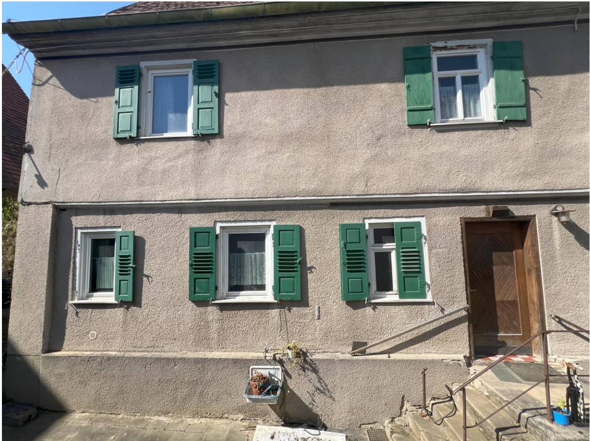
Denkmalgeschütztes Wohnhaus Waldhornstr. 5 / Blick von der Einfahrt
