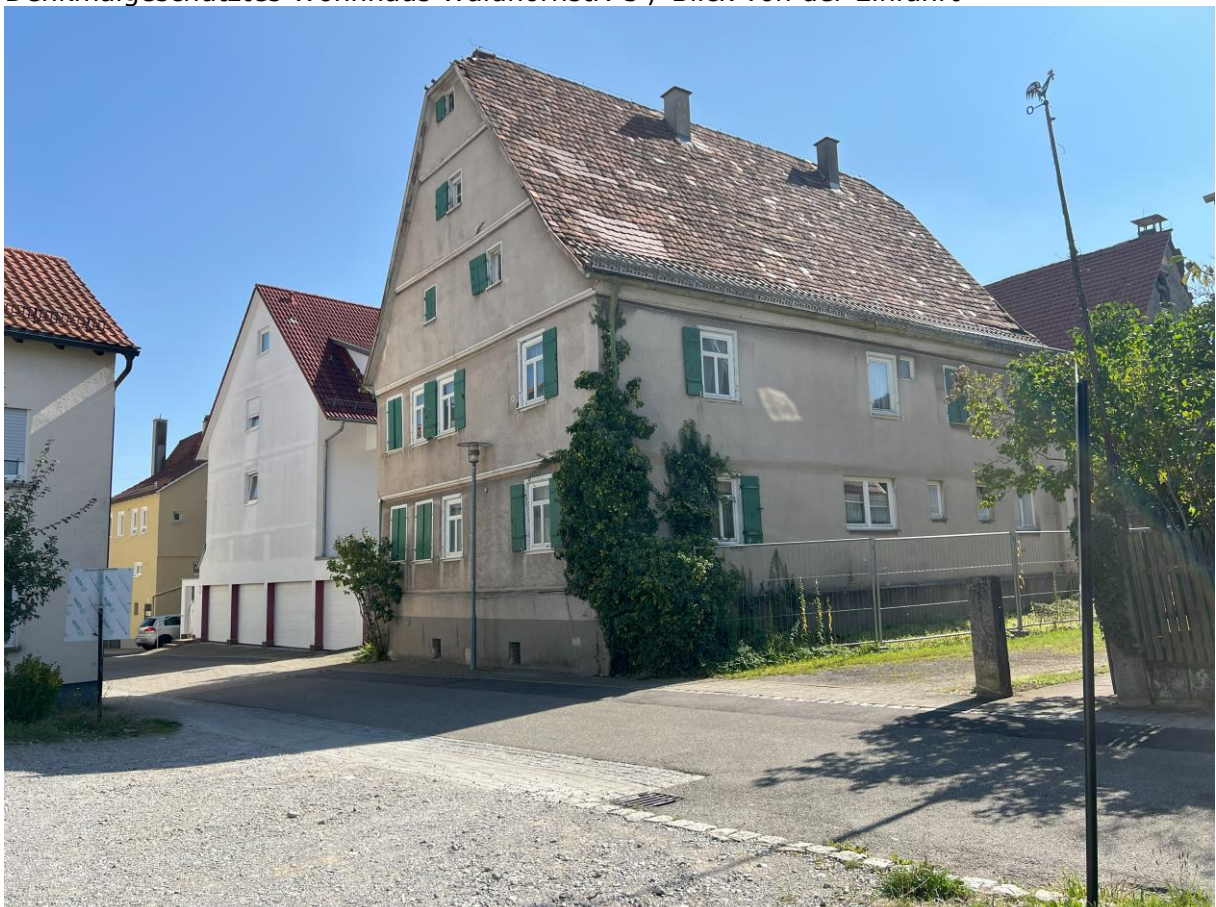
Denkmalgeschütztes Wohnhaus Waldhornstr. 5 / Blick von der Straßen
