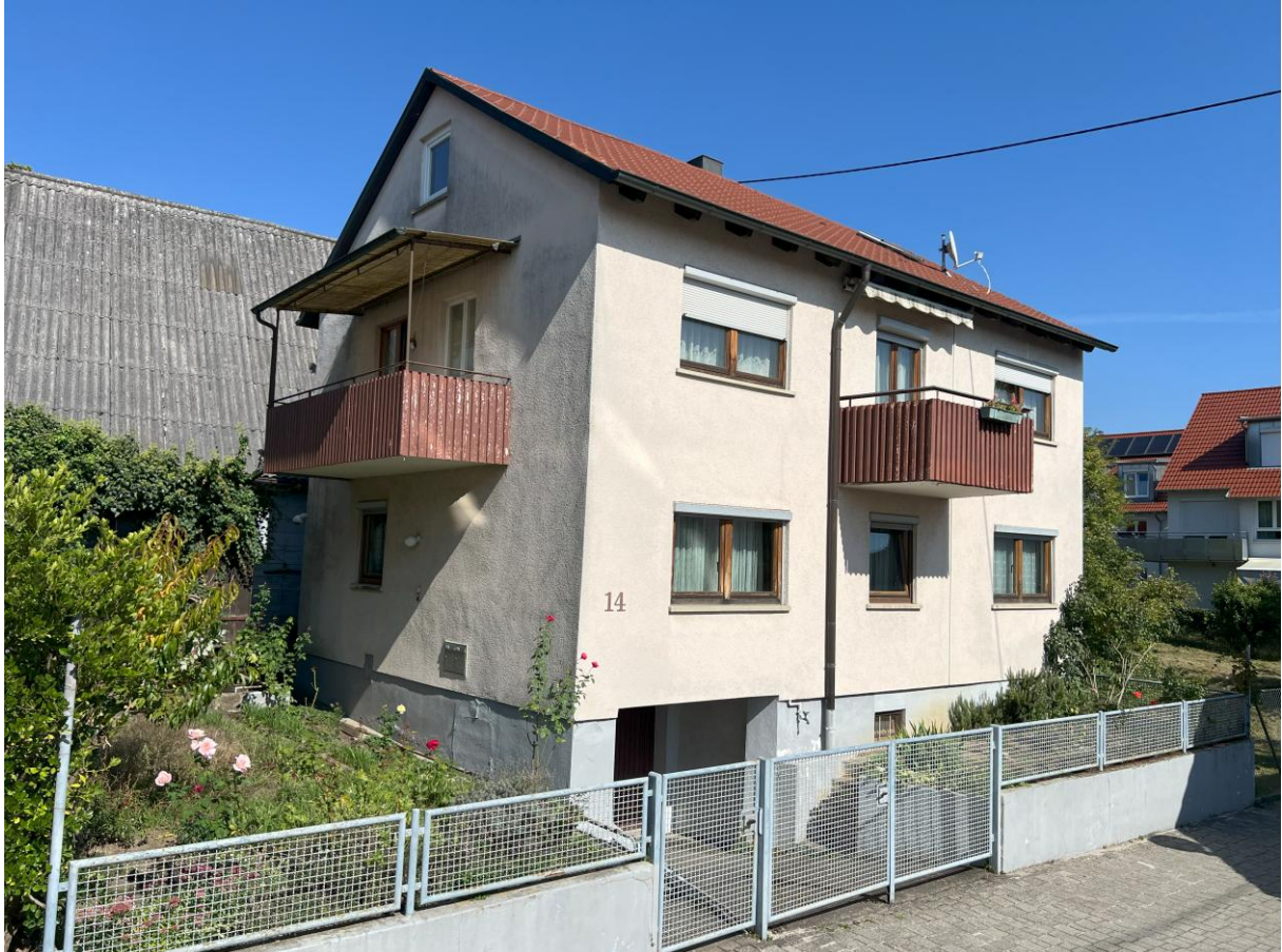
Wohnhaus Hinterhofstr. 14 / links im Hintergrund Scheuer 5/1
