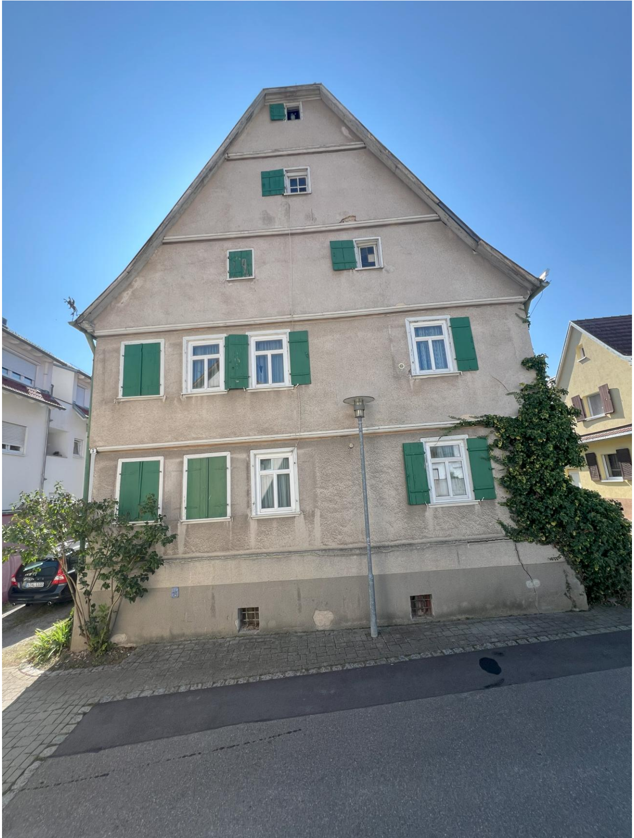
Denkmalgeschütztes Wohnhaus Waldhornstr. 5 / Straßenfront
