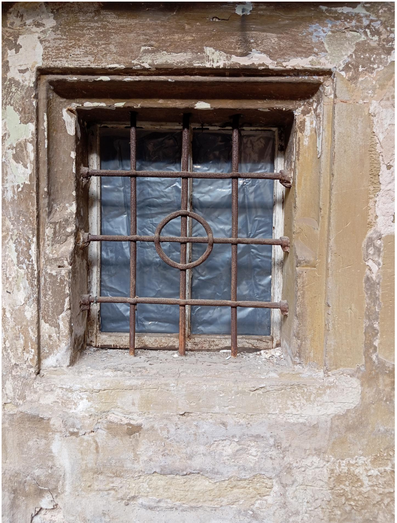
Fenstergitter mit Steineinfassung
