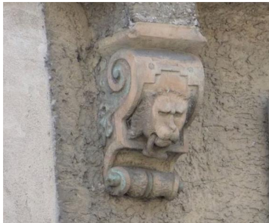
Wohnhaus Ittlinger Straße 40 / Detail Steinkonsole Fassade
