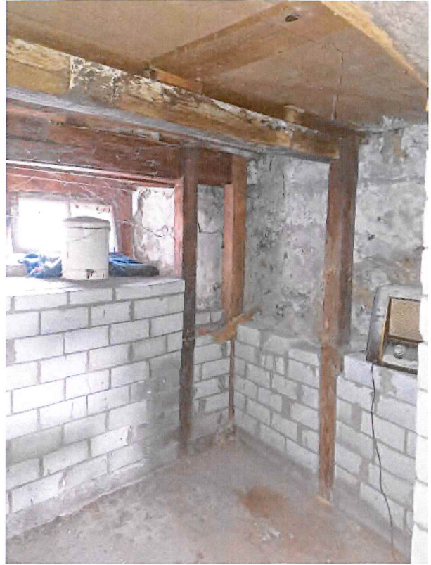
Einbauten/ Sicherungswände aus Kalksandstein im Keller
