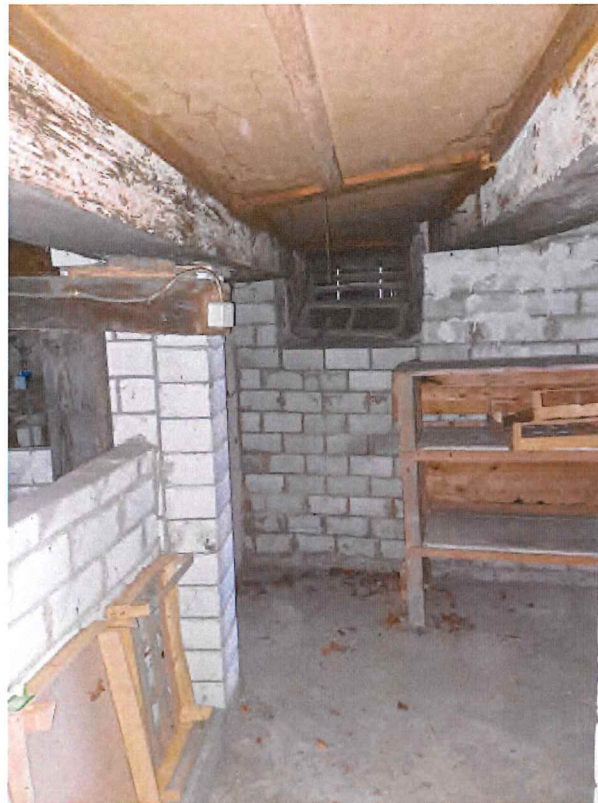
Einbauten/ Sicherungswände aus Kalksandstein im Keller
