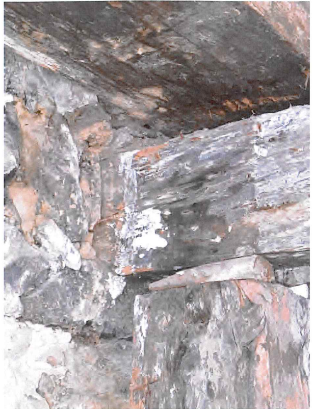
Auflagerbereich Balkenlage im Aussenmauerwerk → genauer Zustand unbekannt
