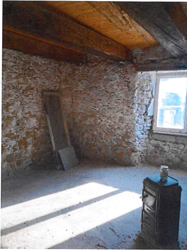
Stube EG – Bruchsteinmauerwerk und Balkenlage Bestand
