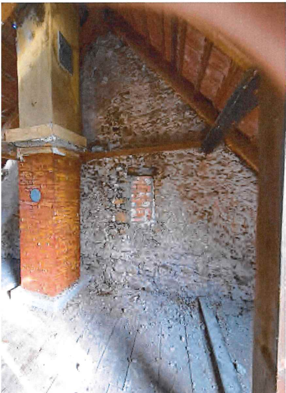
bestehender Dachstuhl → mehrfach umgebaut, Dachneigung Richtung Fachwerkanbau abgeändert
