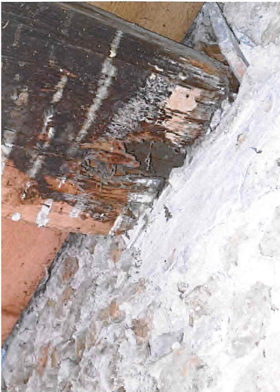
Auflagerbereich Balkenlage im Aussenmauerwerk → genauer Zustand unbekannt
