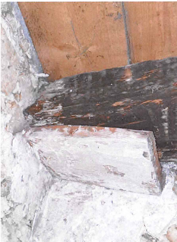
Auflagerbereich Balkenlage im Aussenmauerwerk → genauer Zustand unbekannt
