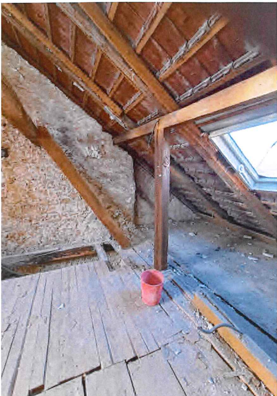
bestehender Dachstuhl → mehrfach umgebaut, Dachneigung Richtung Fachwerkanbau abgeändert
