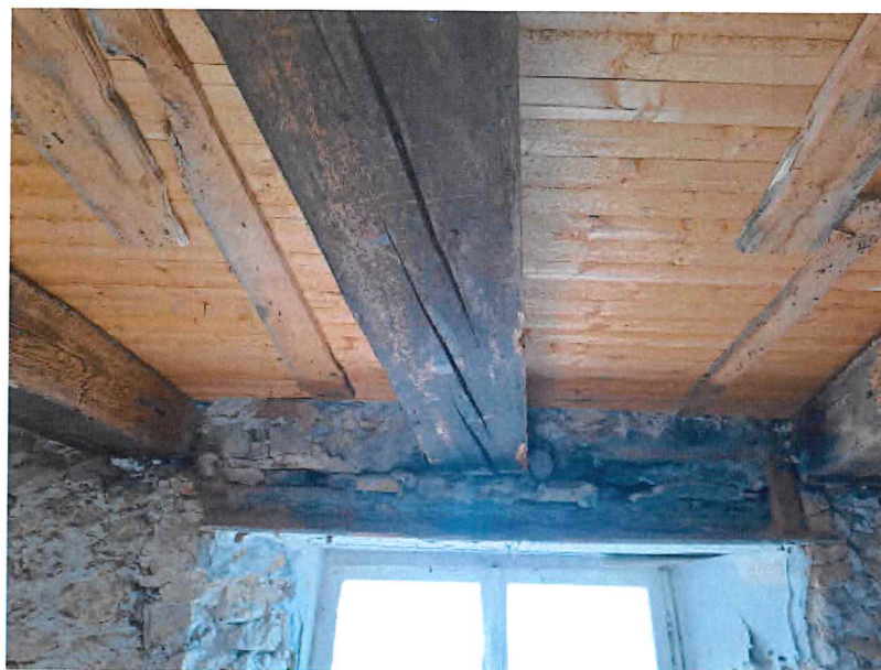
Auflagerbereich Balkenlage Bestand im Aussenmauerwerk
