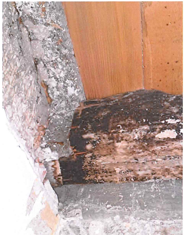
Auflagerbereich Balkenlage im Aussenmauerwerk → genauer Zustand unbekannt
