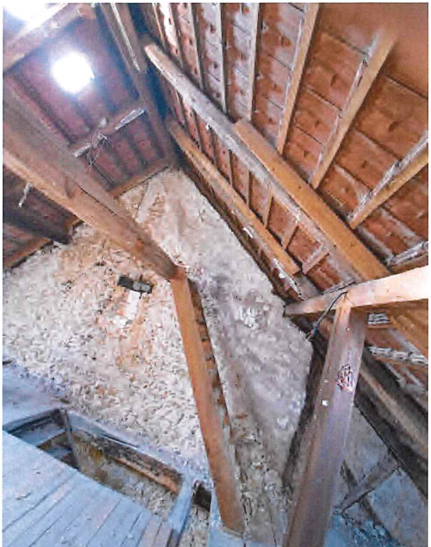
bestehender Dachstuhl → mehrfach umgebaut, Dachneigung Richtung Fachwerkanbau abgeändert
