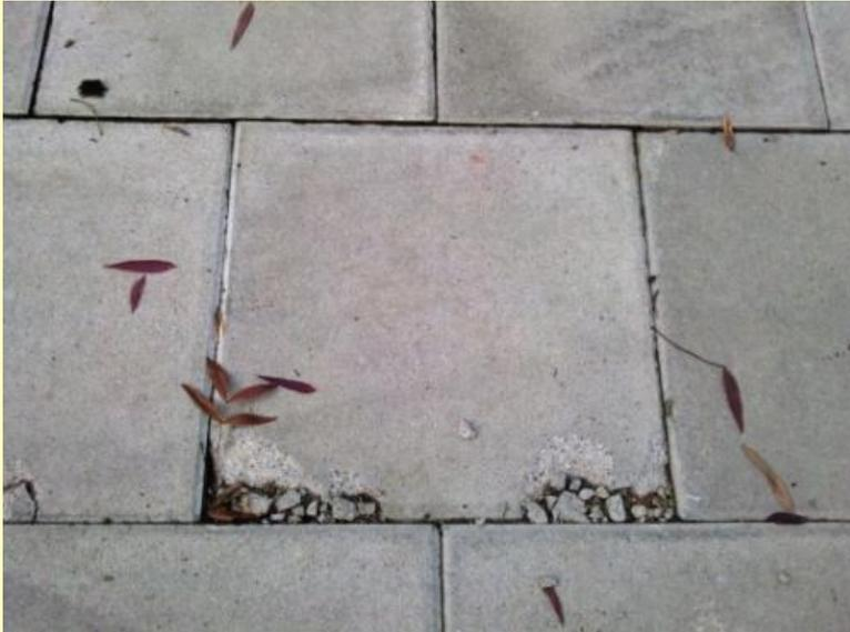
Verlegen mit Normfuge 3-5 mm vermeidet **Abplatzen** = Vertiefungen, in denen sich Feinanteile („Substrat“) ansammeln
