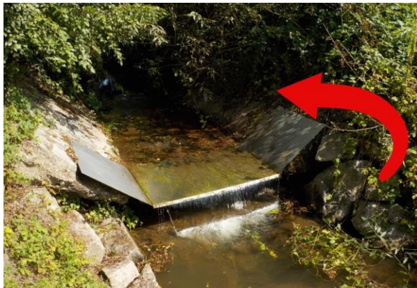
Krebsperre im Wollbach. Die Sperre ist über den Landweg (siehe Pfeil) umwanderbar. (Foto: Günter, C.)
