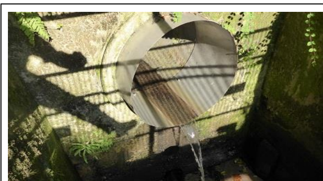
Ausgekleideter Rohrabsturz ohne Leitelemente (Typ 1a) im Heimbach, Stadt Baden-Baden (Foto: Schmieder, B.)
