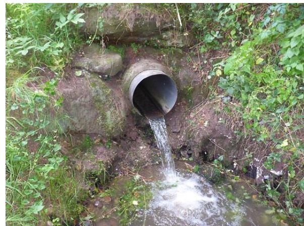
Krebsperre im Heubach nach den Wartungsarbeiten. (Foto: Schmieder, B.)
