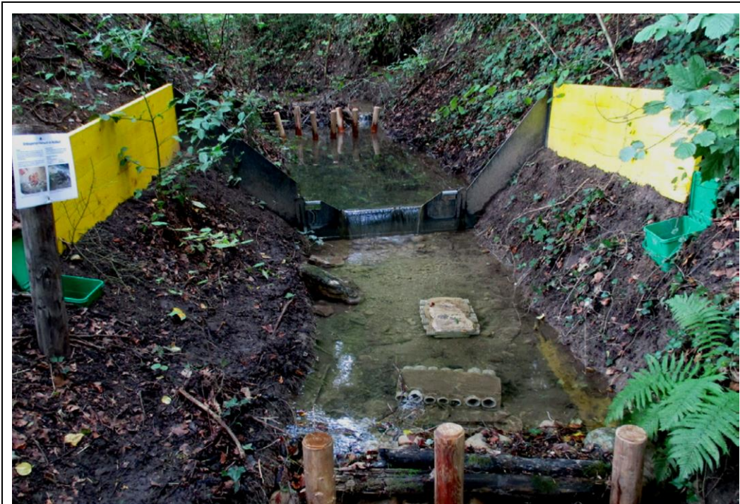
Im Zuge einer wissenschaftlichen Arbeit in der Schweiz konzipierte Leitkonstruktion am Ufer (Foto: ©Koordinationsstelle Flusskrebse Schweiz (KFKS)).
