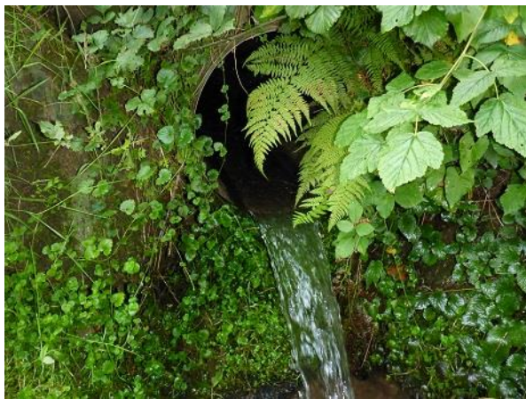
Krebsperre im Heubach vor den Wartungsarbeiten. (Foto: Schmieder, B.)
