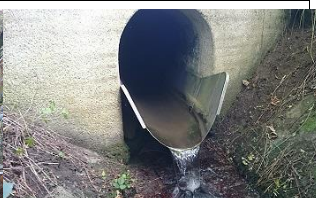
Krebsperre am Finsterbach. Durch den überkragenden Absturz besteht keine Möglichkeit für Flusskrebse mehr, die Struktur zu überwinden. (Foto: Günter, C.)
