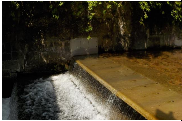
Krebsperre in der Kander. In diesem Fall sind steile, betonierte Uferwände vorhanden, welche Flusskrebse keine Möglichkeit zur Überwindung bieten. (Foto: Günter, C.)
