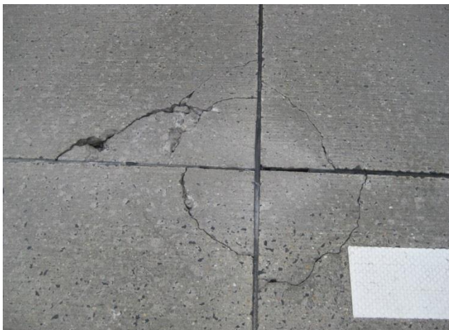
Bild 8: Beispiel für Schadenskategorie IV U - Detail Rissbildung mit beginnender Verschotterung im Fugenkreuz, ohne Verfärbung im Fugenbereich
