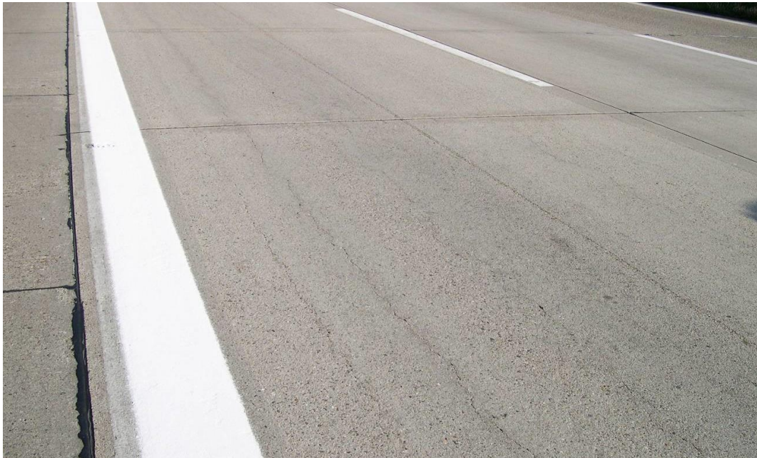
Bild 3: Beispiel für Schadenskategorie II O – Übersicht Längsrissbildung in Rüttelgassen
