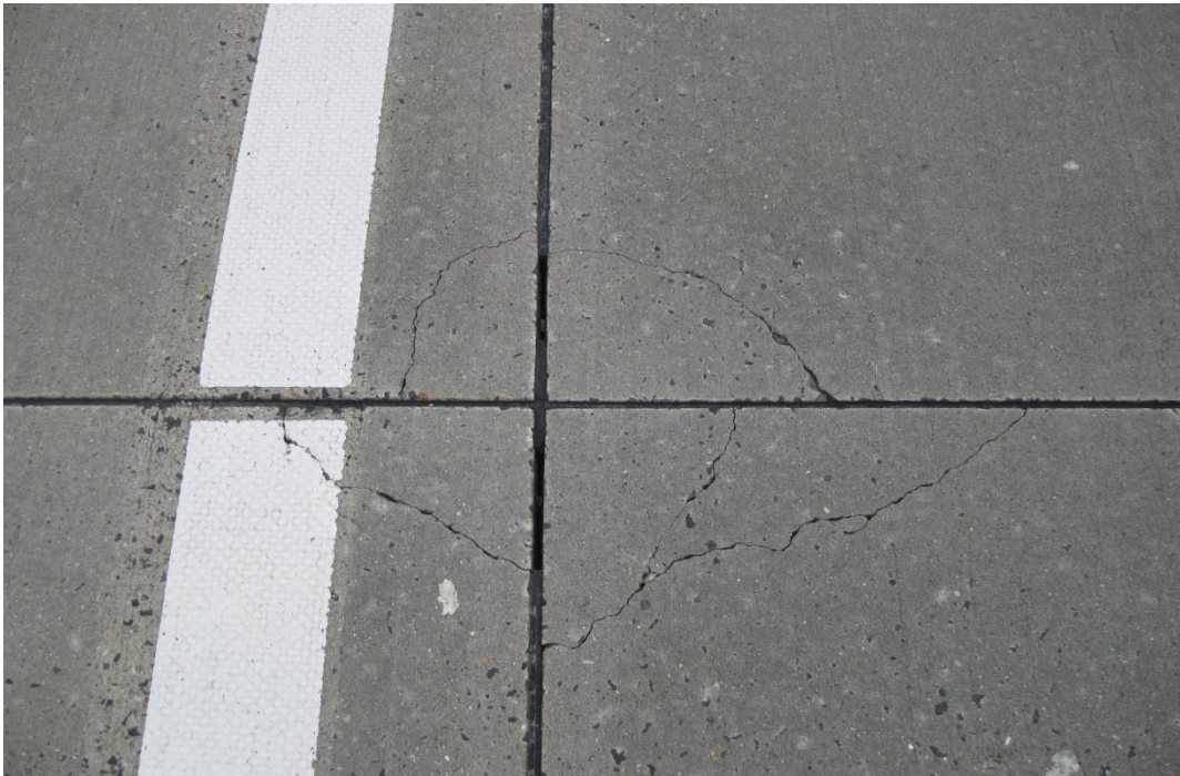
Bild 7: Schadenskategorie IV U - Schäden in den Fugenkreuzen ohne sichtbare Verfärbung
