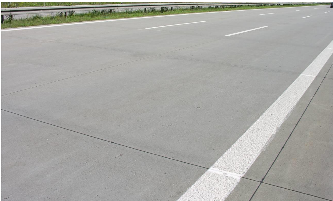
Bild 2: Beispiel für Schadenskategorie I O – Übersicht Verfärbung im Fugenbereich
