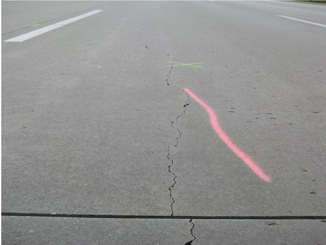
Bild 9: Beispiel für Schadenskategorie IV U – Übersicht Längsrissbildung bei AKR aus Unterbeton
