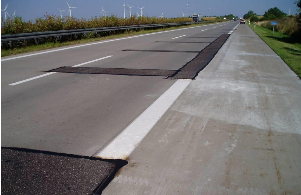
Bild 11: Für das Überbauen mit Asphalt vorbereitete Betondecke mit instandgesetzten Fugenbereichen (ohne Demarkierung)
