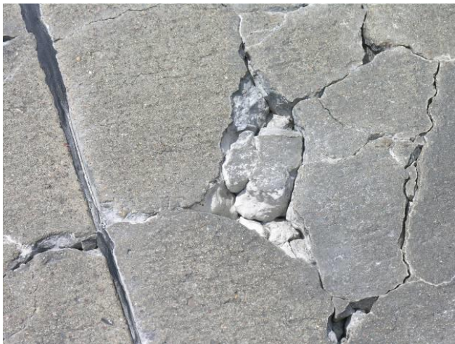
Bild 6: Beispiel für Schadenskategorie III O – Detail Verschotterung
