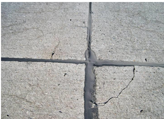
Bild 4: Beispiel für Schadenskategorie II O – Detail Rissbildung im Fugenkreuz
