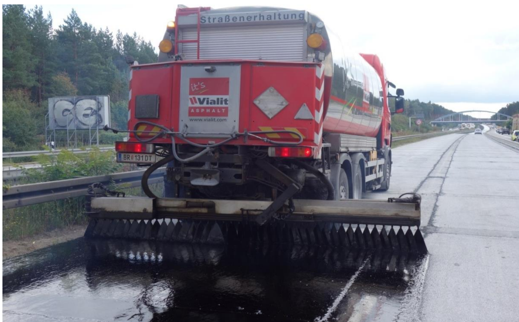
Bild 12: Aufbringen der bitumenhaltigen Zwischenschicht
