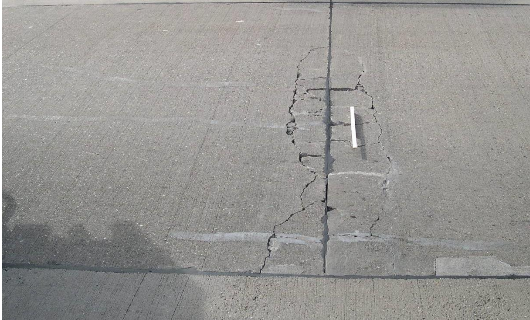
Bild 5: Beispiel für Schadenskategorie III O – Übersicht Verschotterung im Quersfugenbereich
