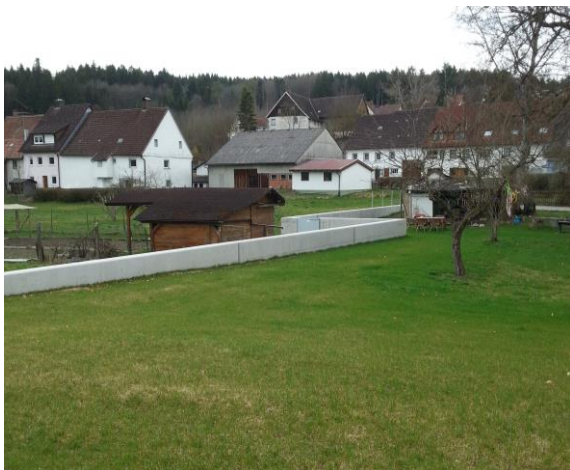
Bild Zustand nach dem Umbau
