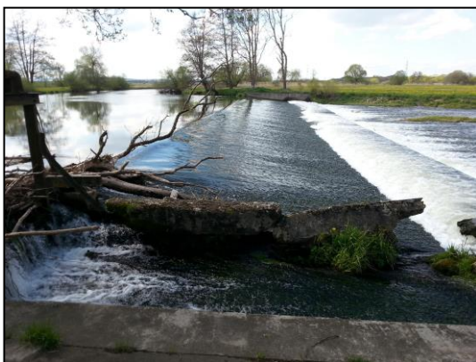
Bild: Zustand vor dem Umbau
