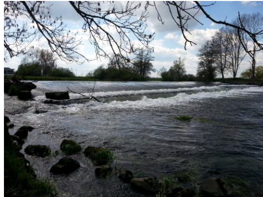
Bild: Zustand vor dem Umbau
