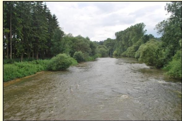
Zustand vor Bau (Blick stromaufwärts von Brücke)
