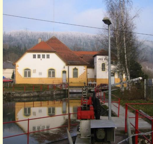
Heute: unpassierbares Querbauwerk durch die Wasserkraftanlage
