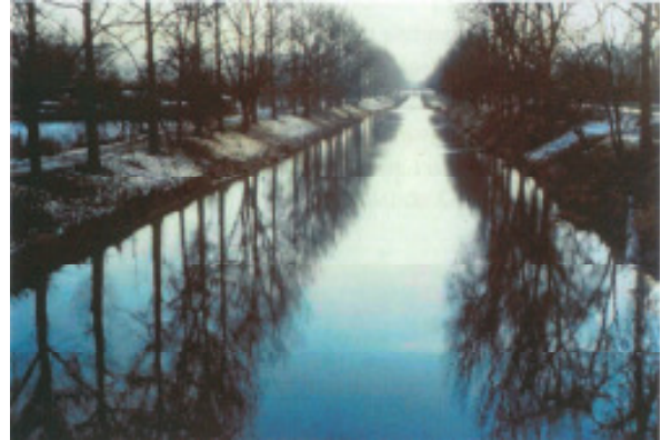
Zustand vor dem Umbau
