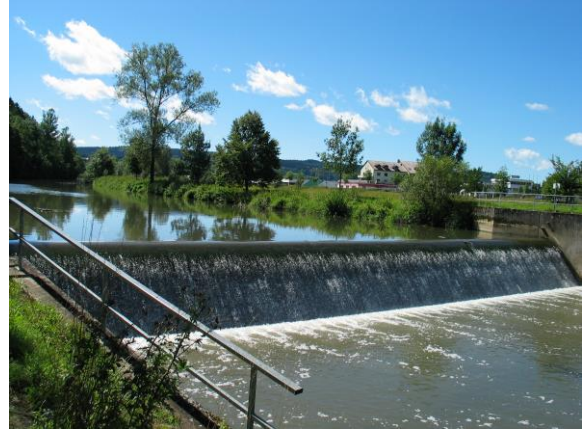
Zustand vor der Umsetzung
