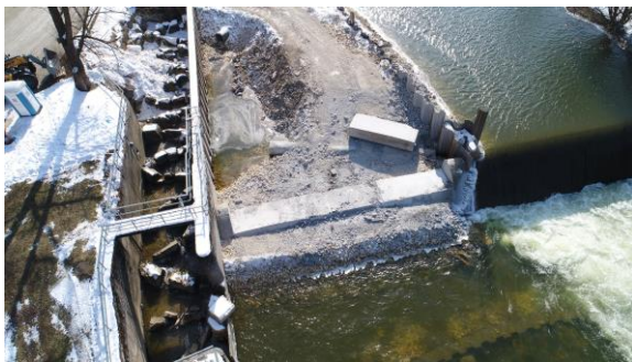
Zustand nach 1. Bauabschnitt
