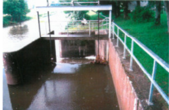
Zustand vor dem Umbau
