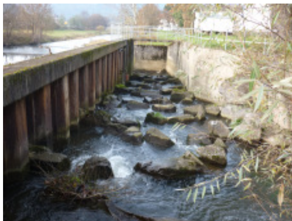
Zustand nach dem Umbau
