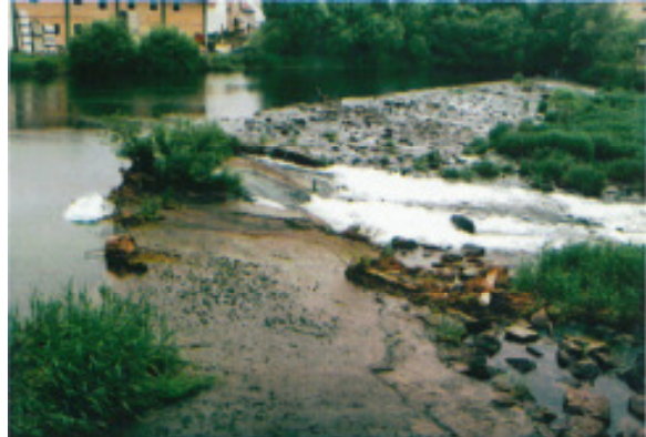
Zustand vor dem Umbau
