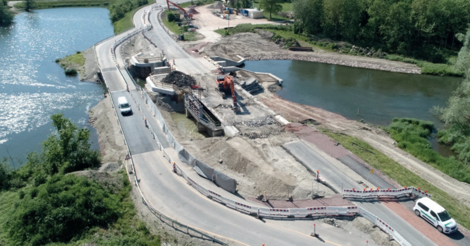
Bau des neuen Durchlassbauwerks im Rückhalteraum Elzmündung
