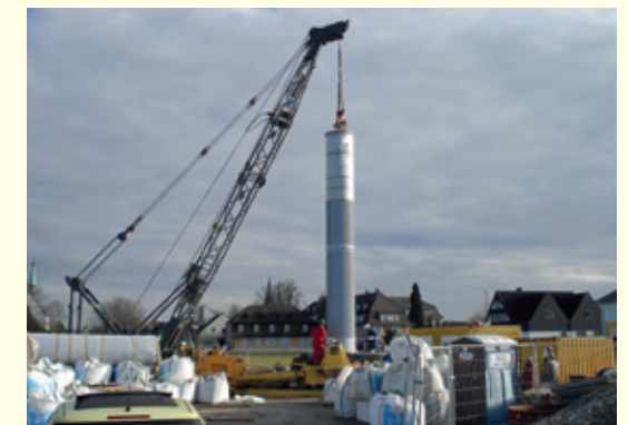
Einbau eines Brunnenrohrs in den Brunnenschacht
