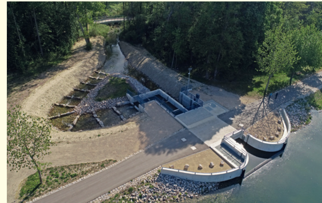
Hochwasserrückhalte- raum Kulturwehr Breisach: Einlaufbauwerk mit Fisch- treppe – Ökologie und Technik Hand in Hand
