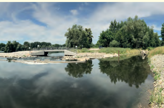
L'ouvrage d'injection de la zone de rétention de l'embouchure de l'Elz
