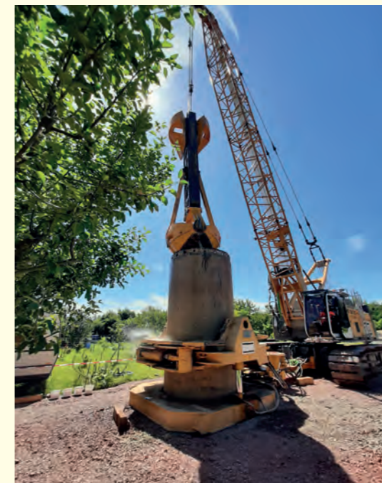
Forage d'un puits
