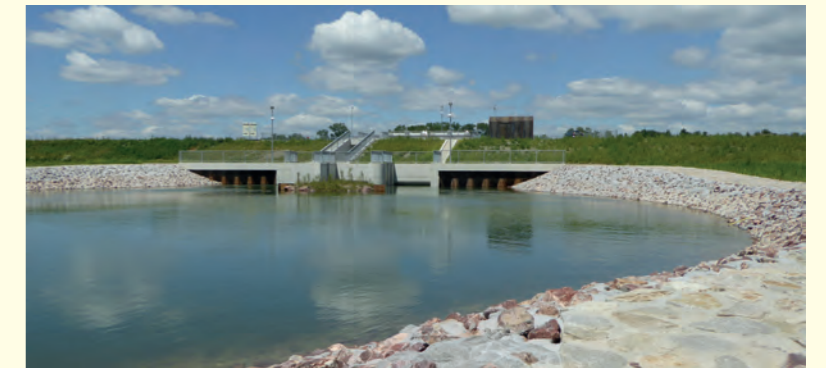
Ouvrage d'injection de la zone de rétention de l'embouchure de l'Elz
