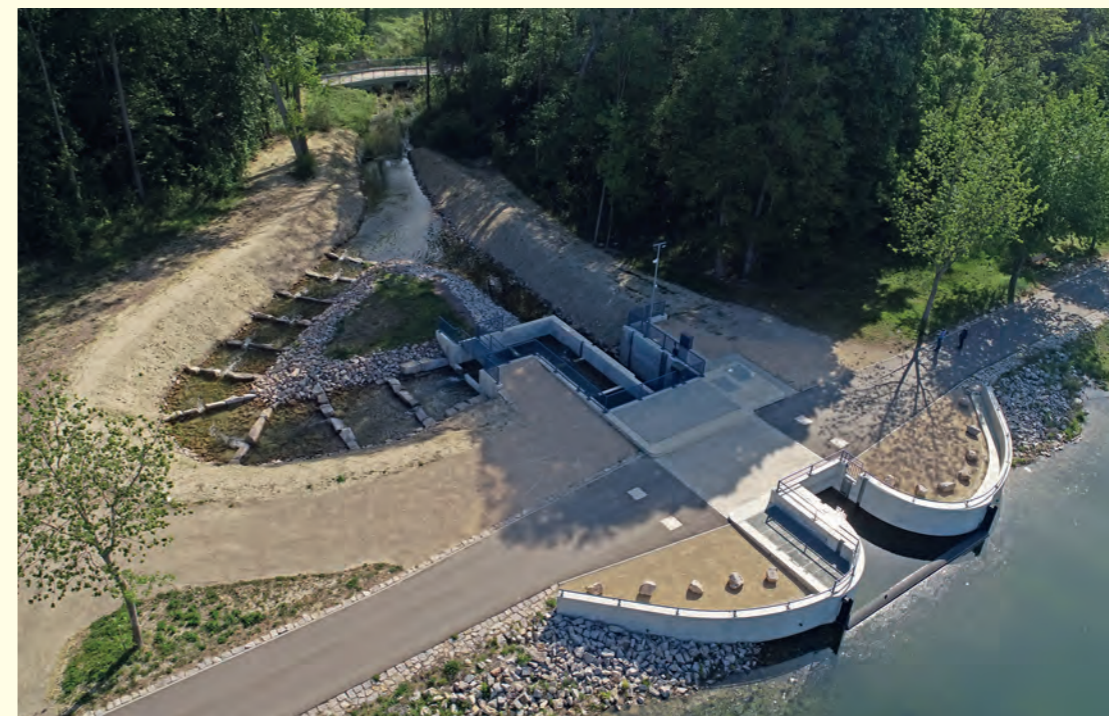
Zone de rétention du barrage agricole de Breisach : ouvrage d'injection avec échelle à poissons – l'écologie et le génie-civil main dans la main
