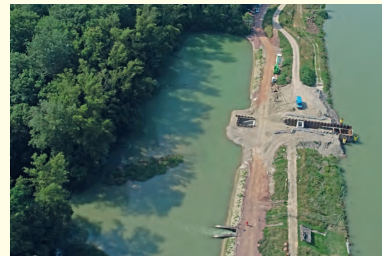
Le chantier d'un des ouvrages d'injection dans la zone de rétention de Breisach/Burkheim
