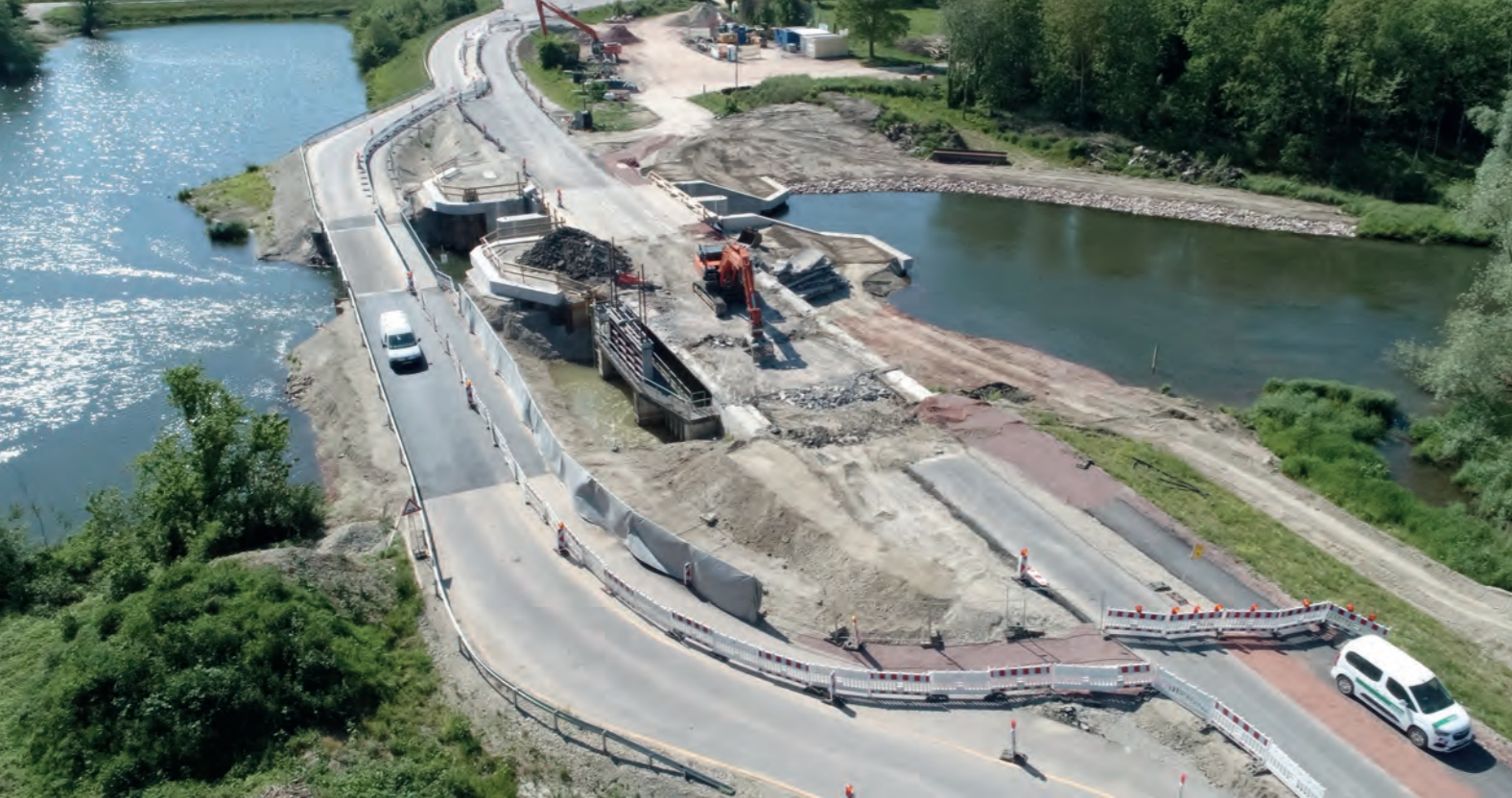
La construction du nouvel ouvrage busé dans la zone de rétention de l'embouchure de l'Elz
