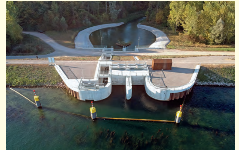
Ouvrage d'injection central de la zone de rétention de l'embouchure de l'Elz
