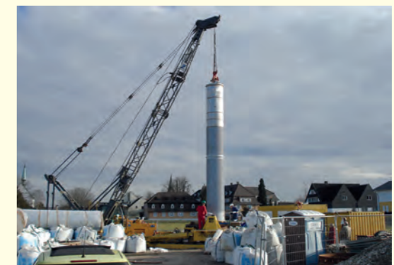
Tubage du puits
