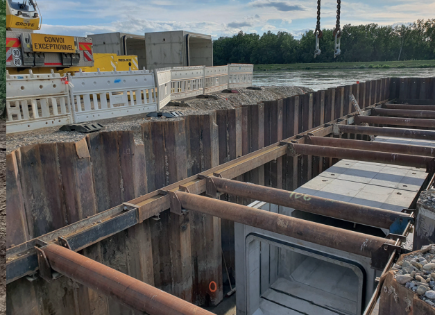
Blick in die Baugrube des kleinen Einlassbauwerks
