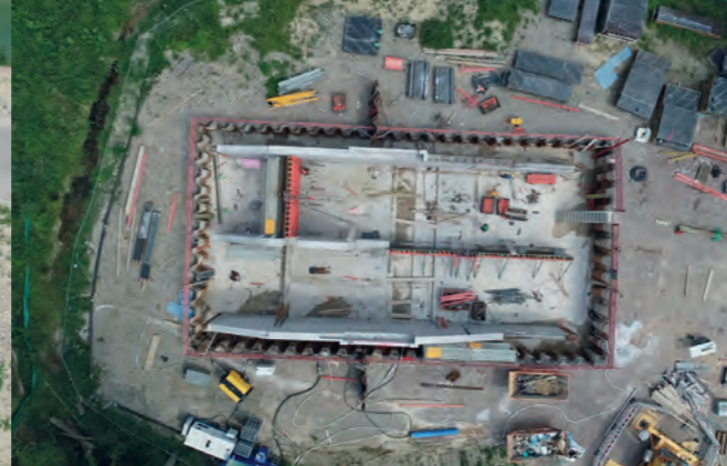
Pumpwerkbaustelle aus der Luft
