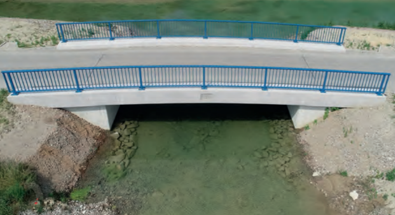
Neue Brücke über einen Entwässerungsgraben
