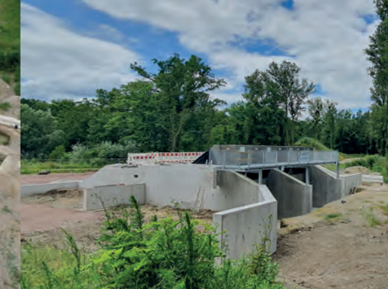
Baustelle Pumpwerk Blauwasser
