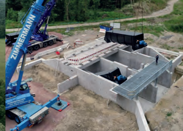
Einsetzen der Schneckenpumpen in das Pumpwerk Blauwasser
