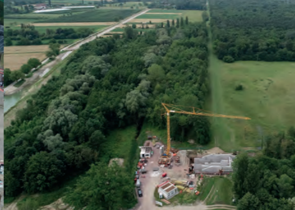
Pumpwerkbaustelle am Hochwasserdamm III
