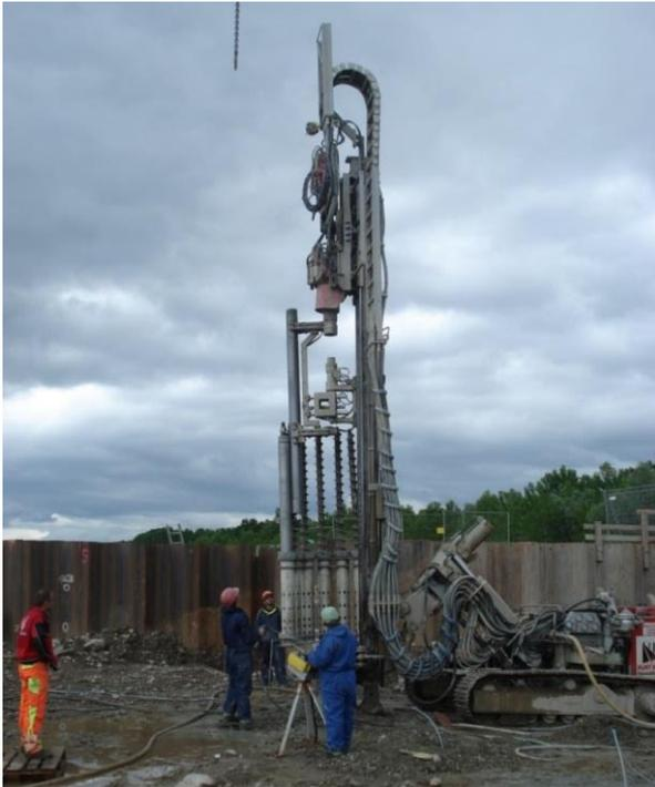
Nachfolgend wurden im Bereich der zukünftigen Baugrubensohle 32 Verankerungspfähle (sog. GEWI-Pfähle) in den Untergrund gebohrt, eingebaut und verpresst. Diese Pfähle dienen dazu, die Unterwasser-betonsohle mit dem Untergrund fest zu verbinden, um zusammen mit den Spundwänden eine trockene Baugrube für die weiteren Arbeiten herzustellen.
