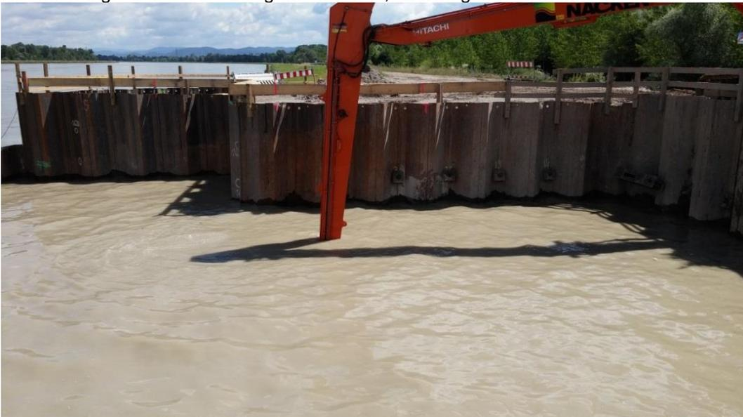
Vor dem Einbringen des Unterwasserbetons müssen noch kleinere Restarbeiten mit Hilfe von Tauchern durchgeführt werden.
