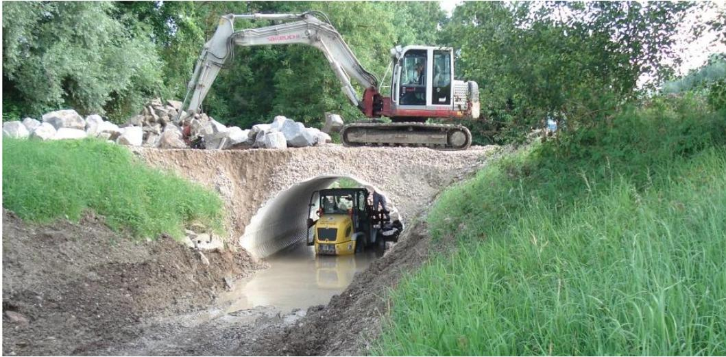
Bis voraussichtlich Mitte August finden die Arbeiten im Seitengraben statt. Dabei wird die Gewässersohle ca. 50 cm abgesenkt, sodass der Anschluss an den Ottenheimer Altrhein ist. Die Uferböschungen werden neu profiliert und durch ingenieurbioologische Strukturelemente ökologisch aufgewertet.
