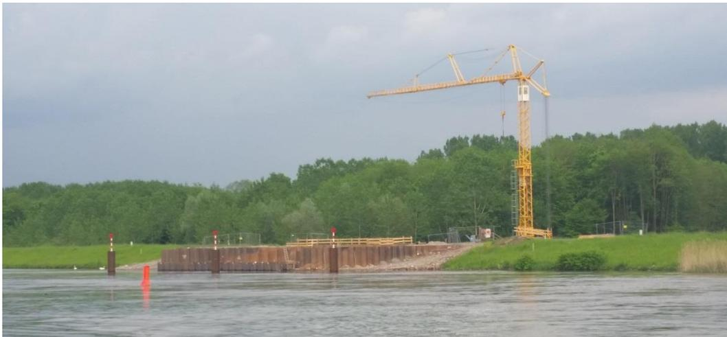
Im nächsten Schritt wurden die für die Standsicherheit des Baugrubenverbaus beim weiteren Aushub erforderlichen Anker gebohrt, eingebaut und verpresst.
