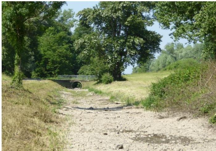
Der alte Rohrdurchlass wurde durch ein größeres „Maulprofil“ ersetzt, in dem eine 70 cm starke Sohle aus natürlichem Sohlsubstrat eingebaut wurde.
